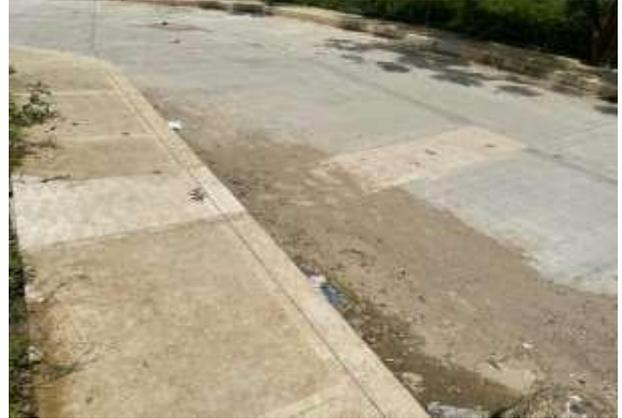
Ilustración 45. Inadecuado proceso de reparación de losa (L/3 de la longitud)
