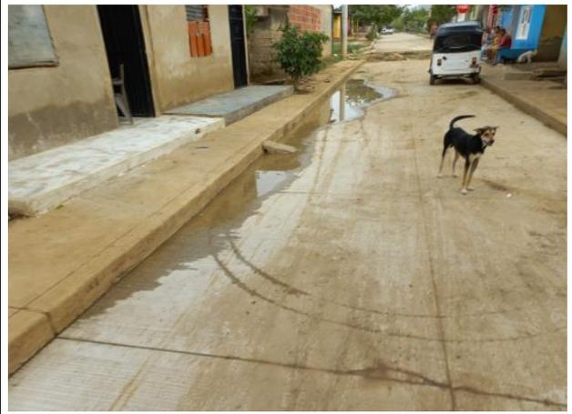
Ilustración 18. Losas con corte superficial longitudinal y transversal desde K0+000 hasta K0+131 y empozamiento de agua en losas entre K0+110 y K0+131.
