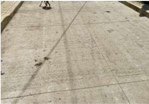
Ilustración 3. Losas con corte superficial longitudinal y transversal desde K0+000 hasta K0+131.
