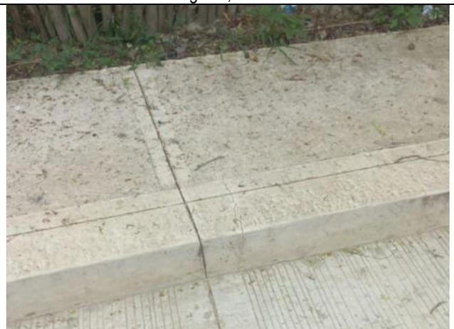
Ilustración 94. Fisura en bordillo y andén
