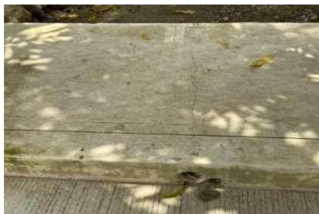
Ilustración 58. Fisura en andén y bordillo en K0+125.
