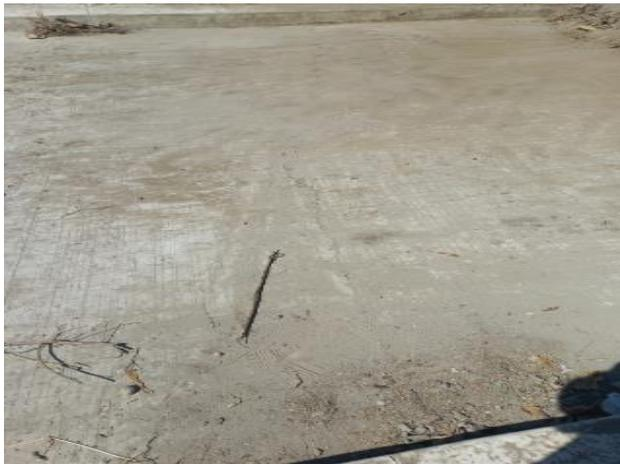
Ilustración 76. Fisura transversal en abscisa K0+50.
