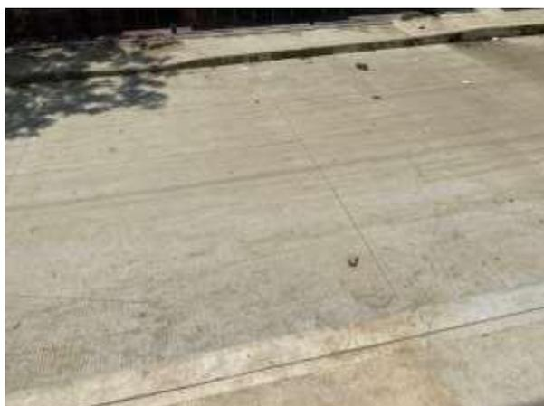
Ilustración 11. Losas con corte superficial longitudinal y transversal desde K0+000 hasta K0+131.
