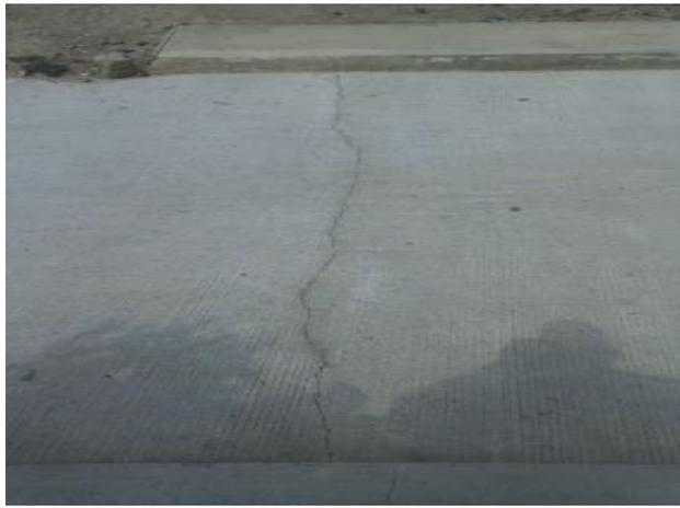
Ilustración 62. Fisura en losa en K0+090.
