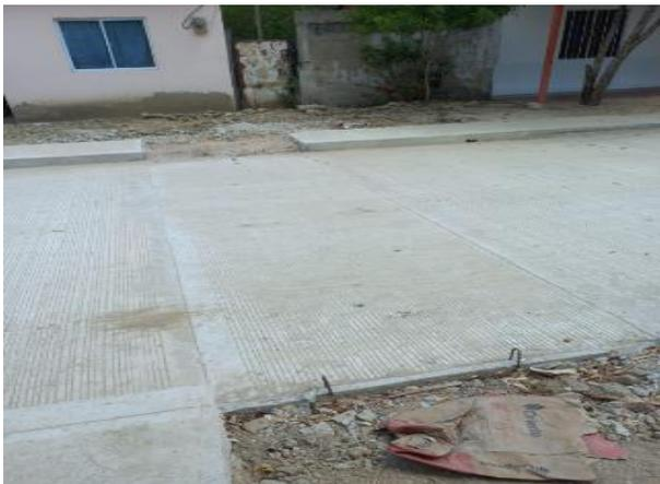
Ilustración 72. Inadecuado procedimiento de reparación de losa, no cumple L/3 de la longitud.
