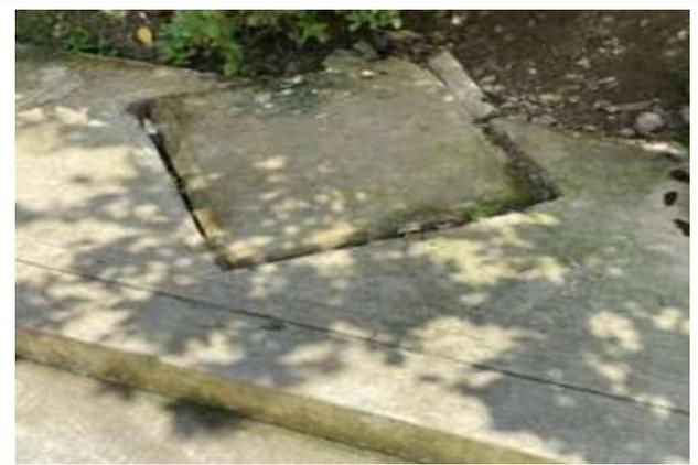
Ilustración 28. Acabado de bordillo con tapa de registro de inadecuada calidad.
