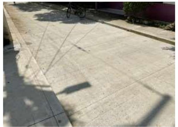
Ilustración 10. Losas con corte superficial longitudinal y transversal desde K0+000 hasta K0+131.
