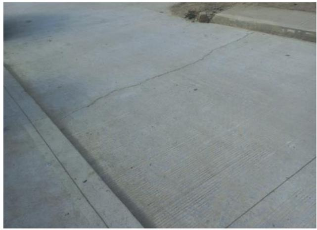
Ilustración 63. Fisura en losa en K0+005.
