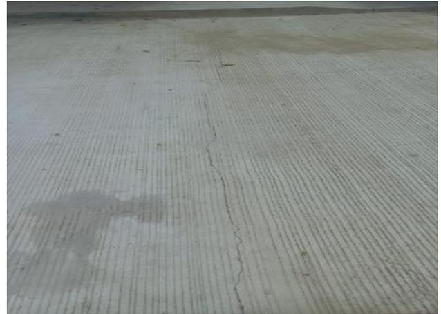
Ilustración 71. Fisura transversal
