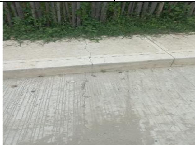
Ilustración 98. Fisura en losa y andén en K0+020.
