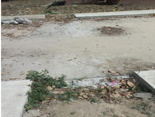
Ilustración 68. Inadecuado procedimiento de reparación de losa, no cumple L/3 de la longitud.
