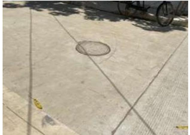
Ilustración 32. Losa de manhole con pérdida de texturizado.
