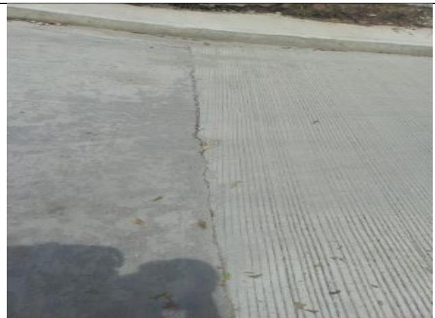
Ilustración 114. Mal procedimiento de empalme de pavimento viejo con nuevo.
