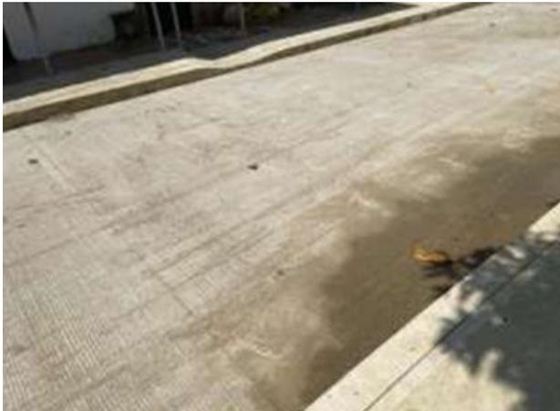
Ilustración 32. Losa con empozamiento de agua, entre abscisas K0+109 hasta K0+121.
