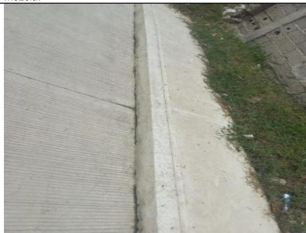
Ilustración 109. Andenes y bordillos con mala dosificación de mezcla.
