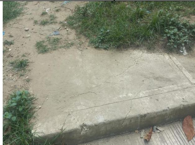
Ilustración 100. Fisura de andén por hundimiento.
