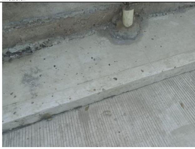
Ilustración 110. Andenes y bordillos con mala dosificación de mezcla.
