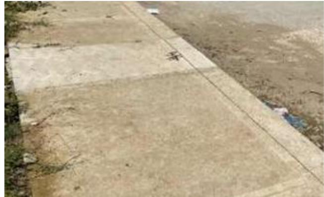
Ilustración 53. Fisura en andén en K0+055.
