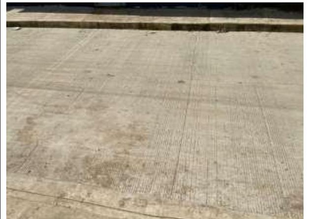
Ilustración 6. Losas con corte superficial longitudinal y transversal desde K0+000 hasta K0+131.
