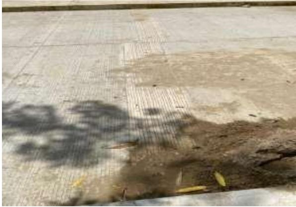
Ilustración 44. Inadecuado proceso de reparación de losa (L/3 de la longitud)
