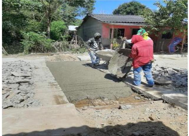
Ilustración 67. Inadecuado procedimiento de reparación de losa, no cumple  $L/3$  de la longitud.
