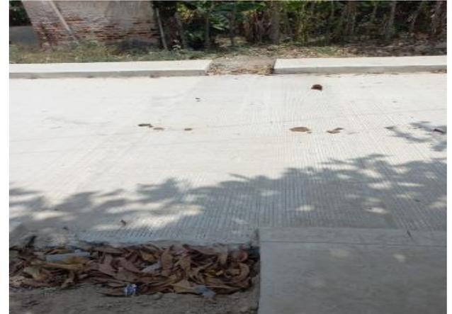
Ilustración 73. Inadecuado procedimiento de reparación de losa, no cumple L/3 de la longitud.
