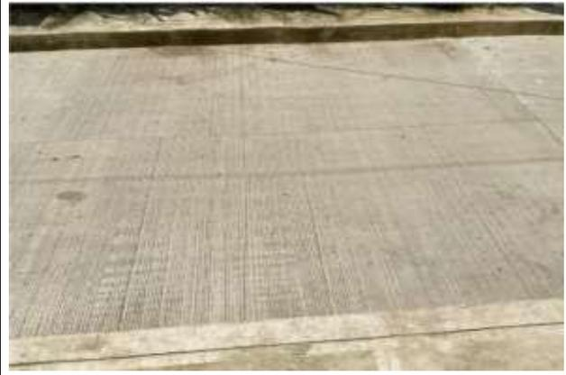
Ilustración 4. Losas con corte superficial longitudinal y transversal desde K0+000 hasta K0+131.
