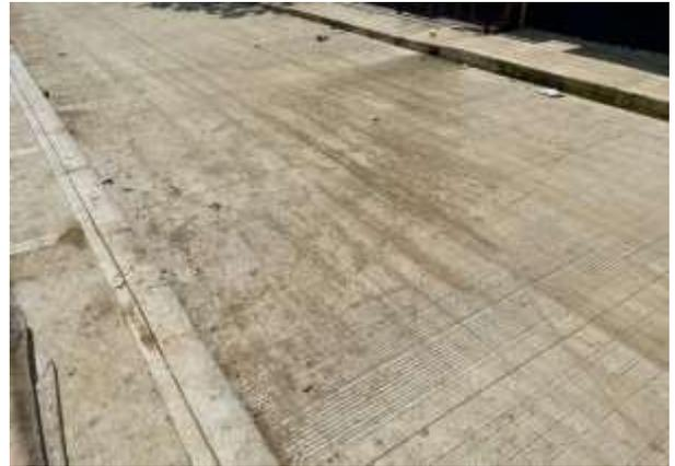
Ilustración 8. Losas con corte superficial longitudinal y transversal desde K0+000 hasta K0+131.
