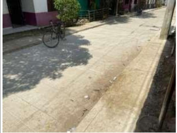
Ilustración 14. Losas con corte superficial longitudinal y transversal desde K0+000 hasta K0+131.
