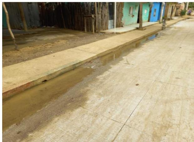
Ilustración 19. Losa con corte superficial longitudinal y transversal desde K0+000 hasta K0+131 y empozamiento de agua en losas entre K0+070 y K0+100.
