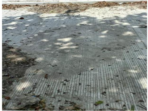
Ilustración 75. Fisura transversal en abscisa K0+55.
