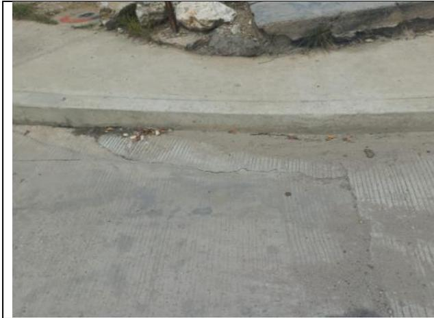
Ilustración 111. Mal proceso constructivo, la losa debe estar con una figura geométrica uniforme.
