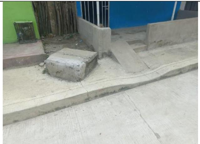
Ilustración 92. Mal procedimiento de construcción de andén sobre el registro, losa con fisura.
