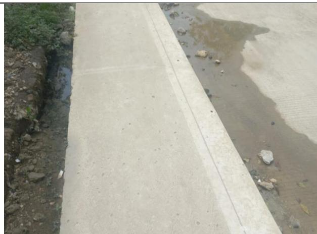
Ilustración 105. Andenes y bordillos con mala dosificación de mezcla.
