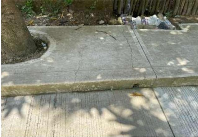
Ilustración 25. Bordillos y andenes con fisuras en carrera 30.
