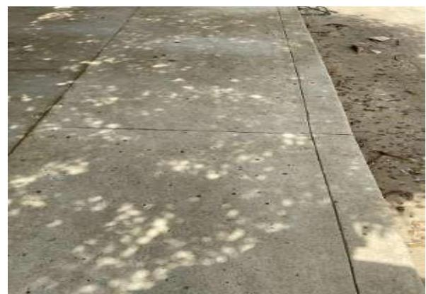
Ilustración 59. Desgaste superficial de andén en K0+160.
