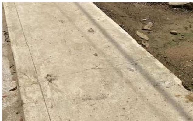
Ilustración 57. Fisura en andén en K0+105.
