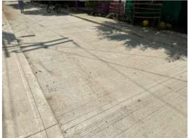
Ilustración 12. Losas con corte superficial longitudinal y transversal desde K0+000 hasta K0+131.
