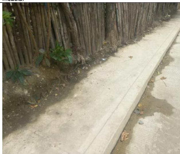
Ilustración 107. Andenes y bordillos con mala dosificación de mezcla.
