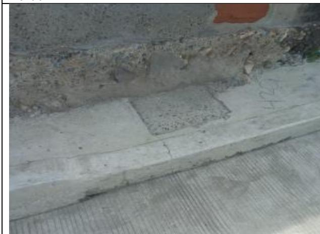
Ilustración 115. Malos acabados de andenes y bordillos con fisura.
