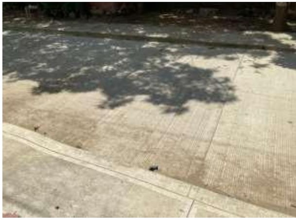
Ilustración 13. Losas con corte superficial longitudinal y transversal desde K0+000 hasta K0+131.
