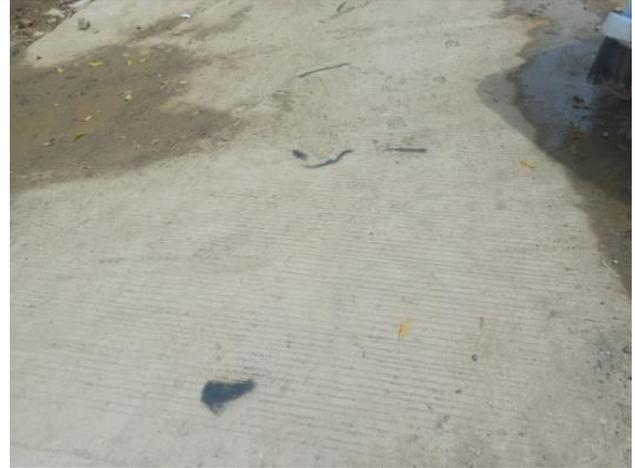
Ilustración 102. Losas con mal procedimiento de construcción, deben ser demolidas K0+065.
