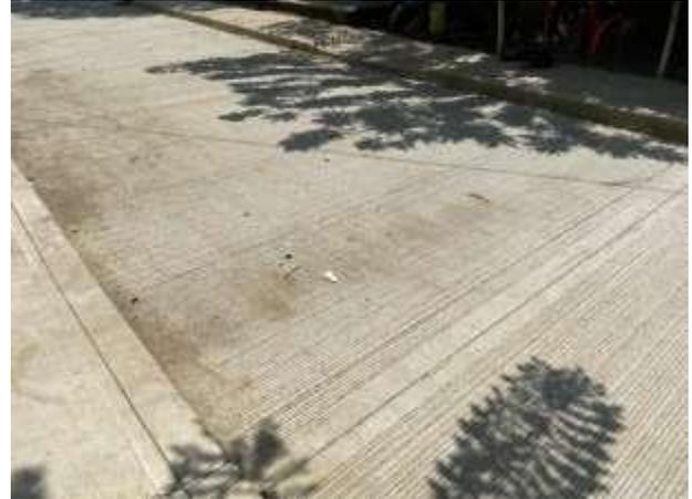
Ilustración 34. Losa con empozamiento de agua, entre abscisas K0+030 hasta K0+40.
