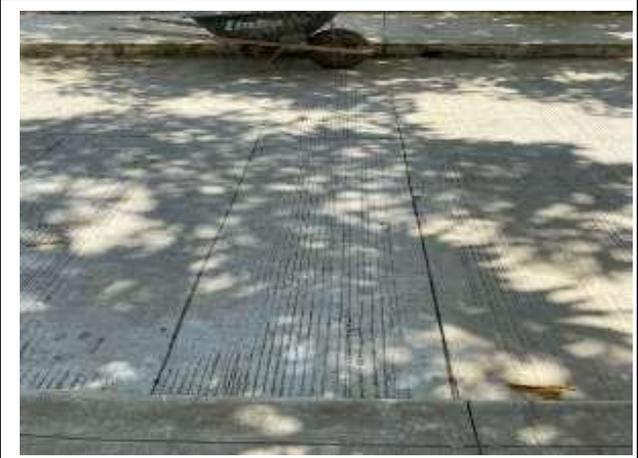
Ilustración 14. Losas con corte superficial longitudinal y transversal desde K0+000 hasta K0+131.
