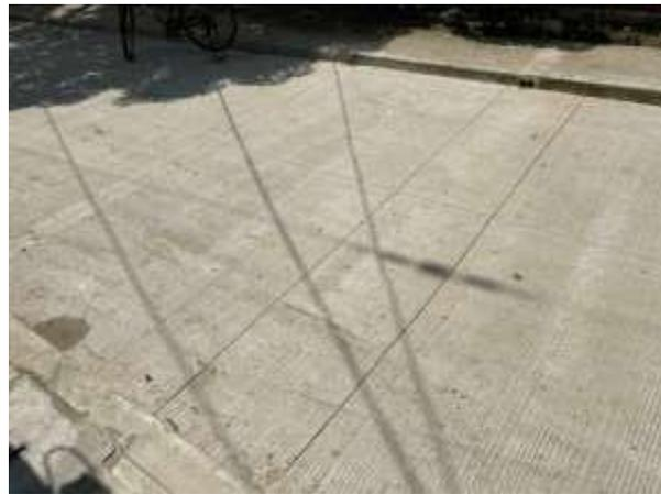
Ilustración 9. Losas con corte superficial longitudinal y transversal desde K0+000 hasta K0+131.
