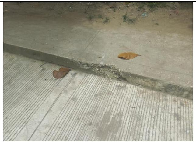
Ilustración 81. Mal acabado de bordillo K0+050.
