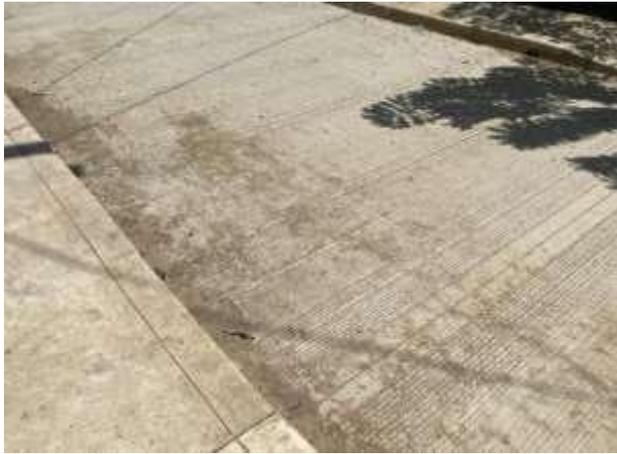
Ilustración 33. Losa con empozamiento de agua, entre abscisas K0+030 hasta K0+40.
