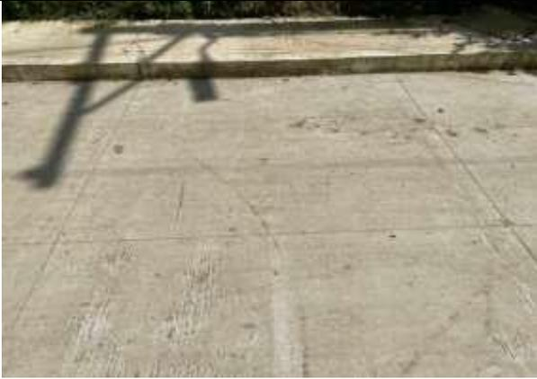
Ilustración 1. Losa con pérdida de texturizado, carrera 30 entre las abscisas K0+000 y K0+030.
