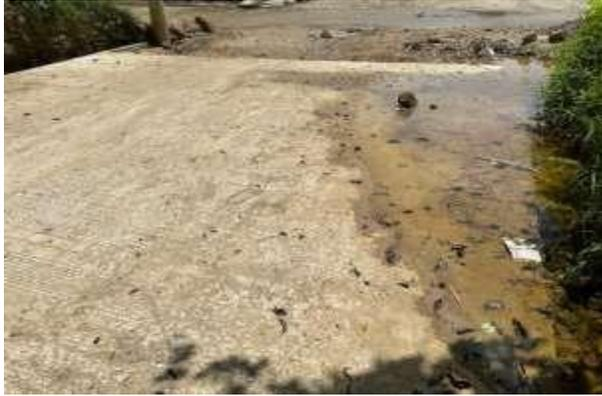
Ilustración 40. Empozamiento de aguas en empalme final K0+243
