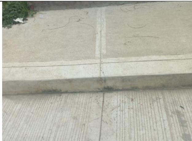
Ilustración 91. Bordillo sin junta de dilatación, se fisuro por estar monolítico.
