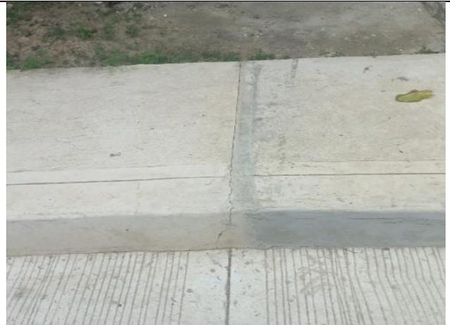
Ilustración 90. Bordillo sin junta de dilatación, se fisuro por estar monolítico.
