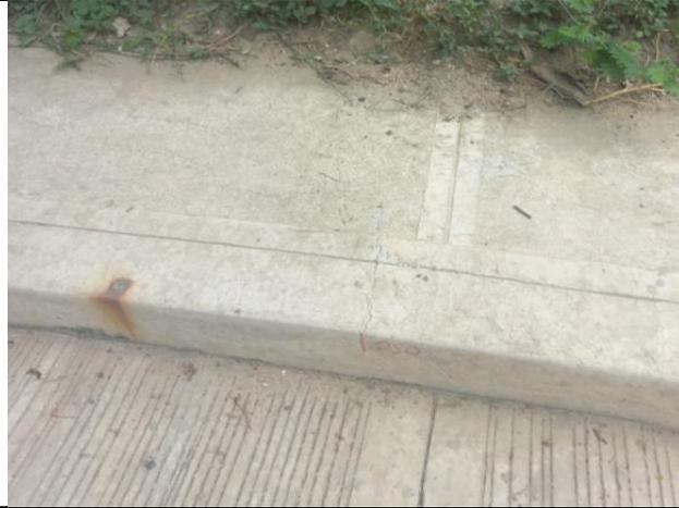
Ilustración 84. Fisura superficial en bordillo y anden.
