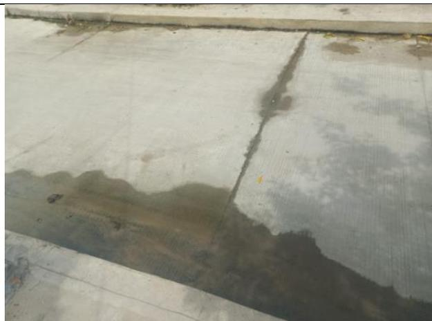
Ilustración 106. Fisura de placa en K0+070.
