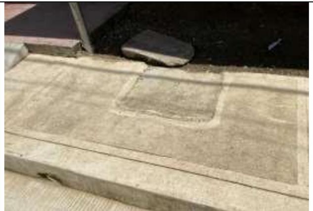
Ilustración 33. Inadecuado acabado de anden con registro.
