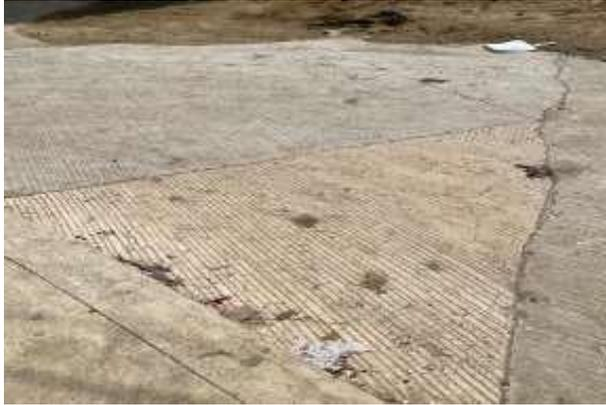
Ilustración 50. Junta de empalme de losa irregular entre pavimento viejo y nuevo K0+000.
