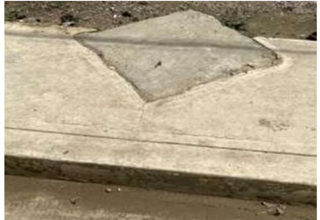
Ilustración 26. Acabado de bordillo con tapa de registro de inadecuada calidad.
