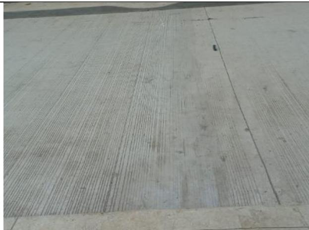
Ilustración 88. Losa con reparación superficial, no cumple normativa invías.
