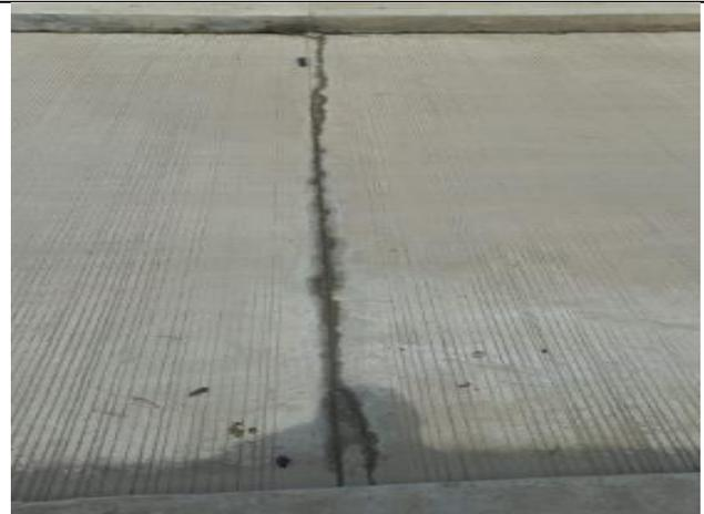
Ilustración 104. Fisuras provocadas por corte de junta de dilatación.
