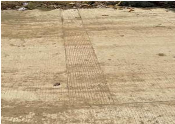
Ilustración 42. Inadecuado proceso de reparación de losa (L/3 de la longitud)
