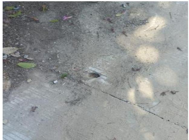
Ilustración 77. Acabado de losa deficiente K0+060.
