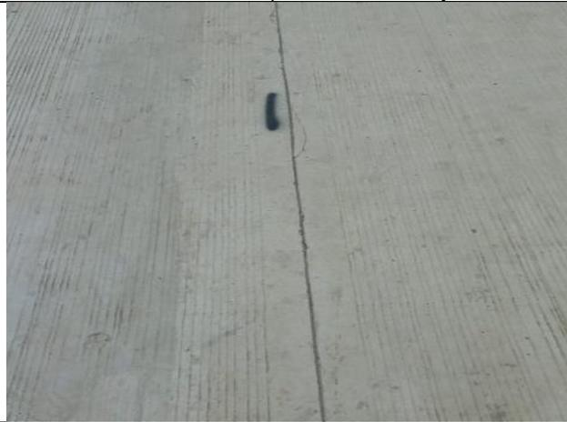
Ilustración 86. Fisura provocada por corte de junta de dilatación.
