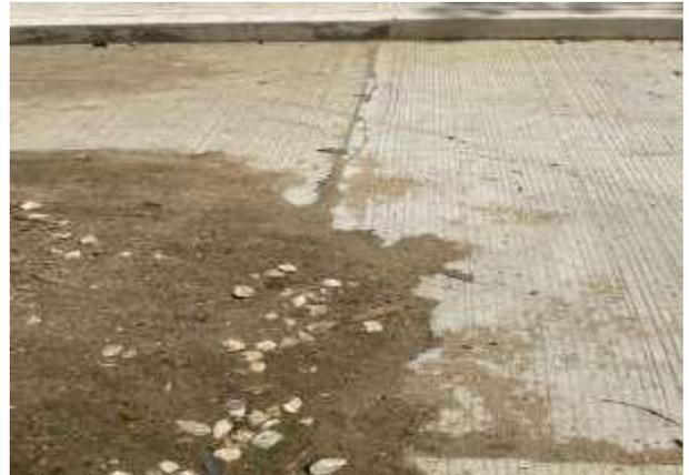
Ilustración 43. Desportillamiento de losa.
