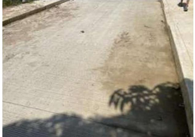
Ilustración 31. Losa con empozamiento de agua, entre abscisas K0+040 hasta K0+060.
