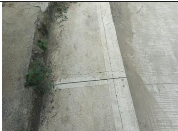
Ilustración 93. Fisura en bordillo y andén
