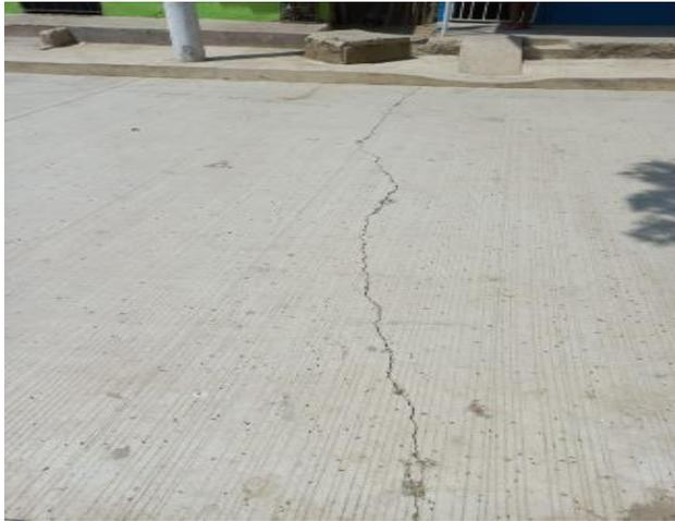
Ilustración 74. Fisura transversal en abscisa K0+035.
