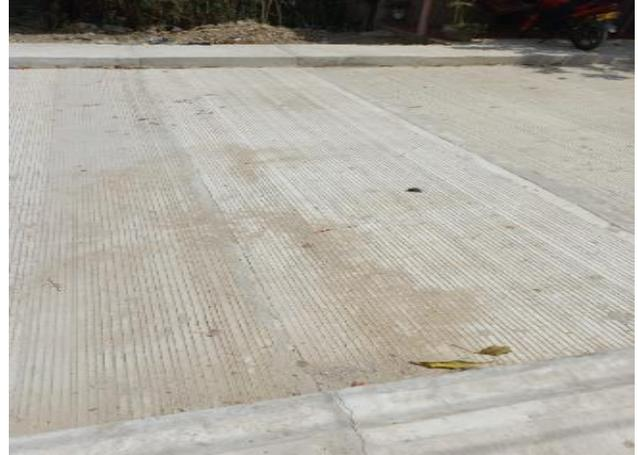
Ilustración 69. Inadecuado procedimiento de reparación de losa, no cumple L/3 de la longitud.
