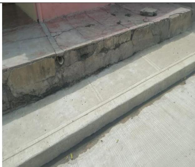
Ilustración 108. Andenes y bordillos con mala dosificación de mezcla.
