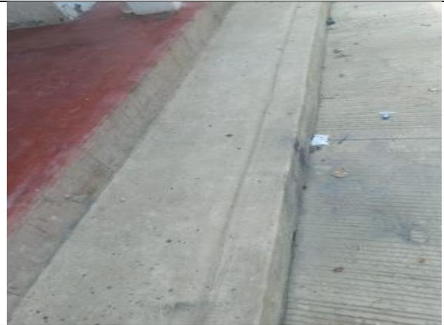
Ilustración 112. Andenes y bordillos con mala dosificación de mezcla.
