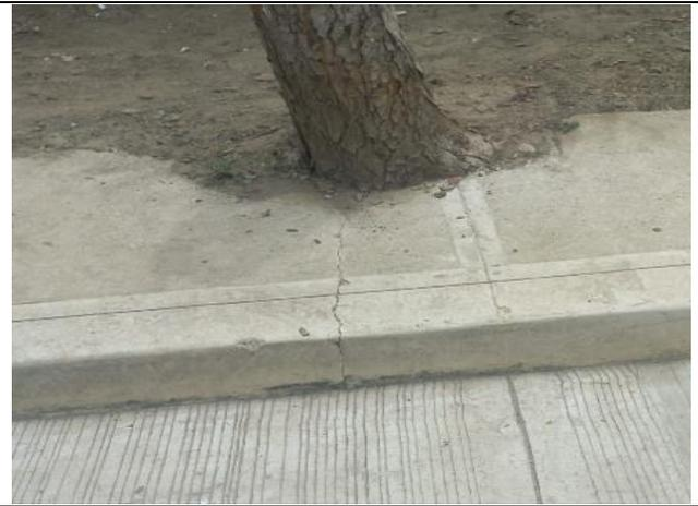
Ilustración 87. Fisura en bordillo y anden por mal procedimiento constructivo.
