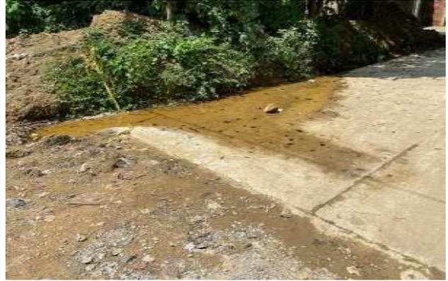
Ilustración 41. Empozamiento de aguas en empalme final K0+243
