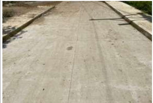
Ilustración 2. Losa con pérdida de texturizado, carrera 30 entre las abscisas K0+000 y K0+030.
