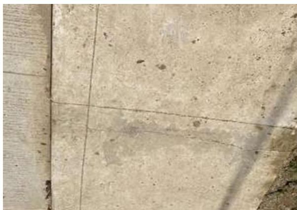
Ilustración 57. Fisura en andén y bordillo en K0+115.
