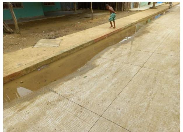
Ilustración 20. Losa con corte superficial longitudinal y transversal desde K0+000 hasta K0+131 y empozamiento de agua en losas entre K0+070 y K0+100.
