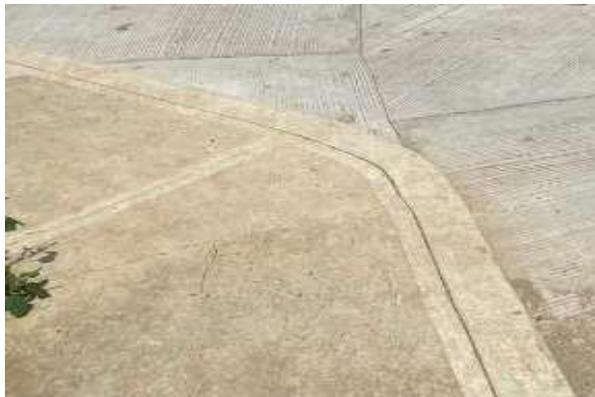
Ilustración 52. Fisura en andén en K0+045.
