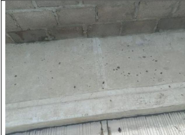
Ilustración 103. Andenes y bordillos con mala dosificación de mezcla.
