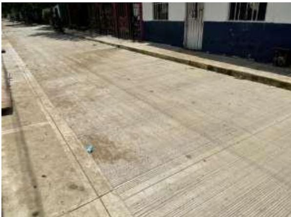
Ilustración 5. Losas con corte superficial longitudinal y transversal desde K0+000 hasta K0+131.
