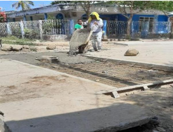
Ilustración 66. Inadecuado procedimiento de reparación de losa, no cumple  $L/3$  de la longitud.
