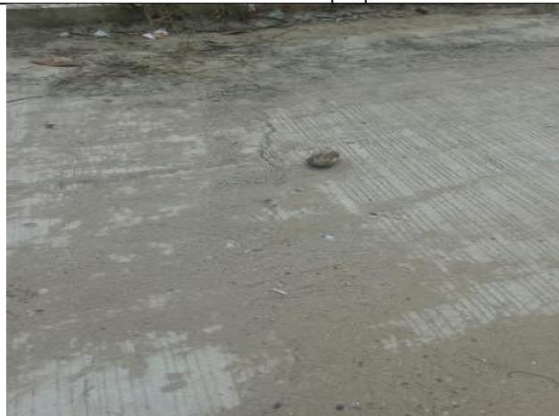
Ilustración 97. Fisura en losa y andén en K0+020.
