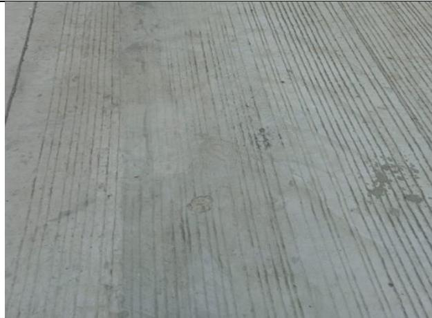
Ilustración 89. Losa con reparación superficial, no cumple normativa invias.
