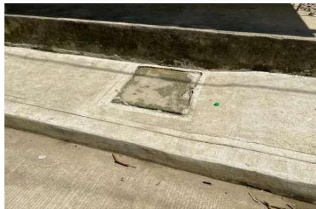
Ilustración 27. Acabado de bordillo con tapa de registro de inadecuada calidad.
