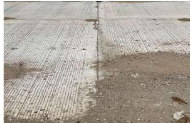
Ilustración 47. Desportillamiento de losa.
