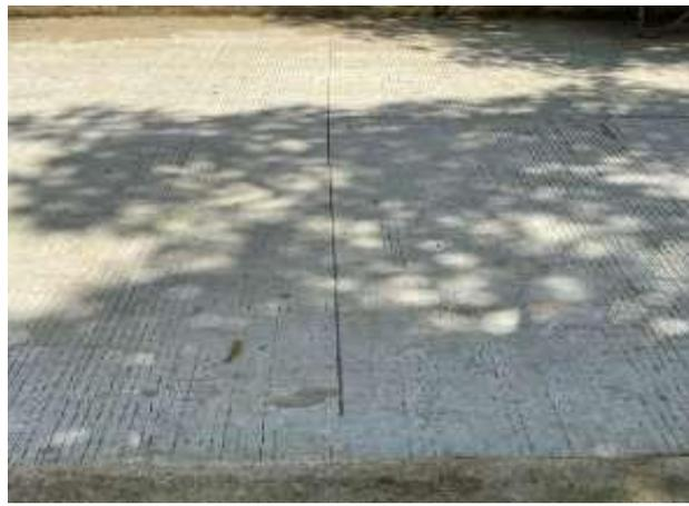
Ilustración 17. Losas con corte superficial longitudinal y transversal desde K0+000 hasta K0+131.
