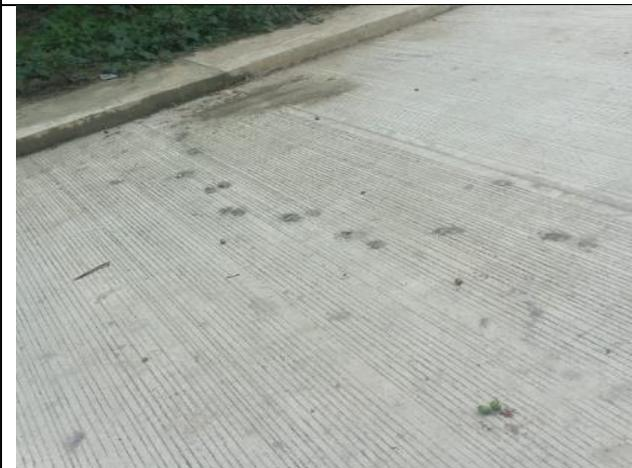
Ilustración 82. Mal acabado de losa en K0+020.
