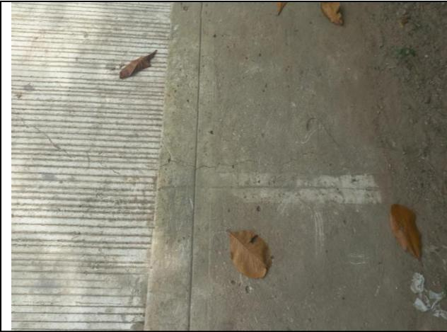
Ilustración 78. Fisura en losa y andén K0+068.
