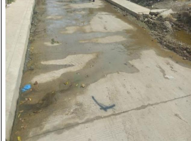
Ilustración 101. Losas con mal procedimiento de construcción, deben ser demolidas K0+060.
