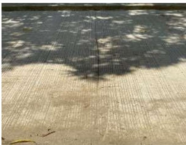
Ilustración 15. Losas con corte superficial longitudinal y transversal desde K0+000 hasta K0+131.
