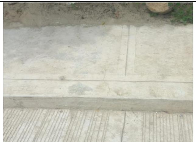
Ilustración 83. Fisura superficial en bordillo y andén.
