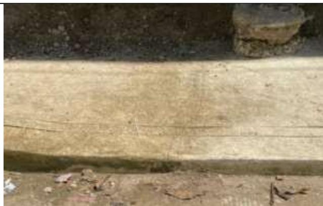
Ilustración 29. Bordillos y andenes con fisuras en carrera 30.
