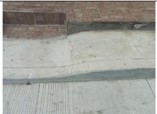
Ilustración 89. Anden y bordillo con fisura.
