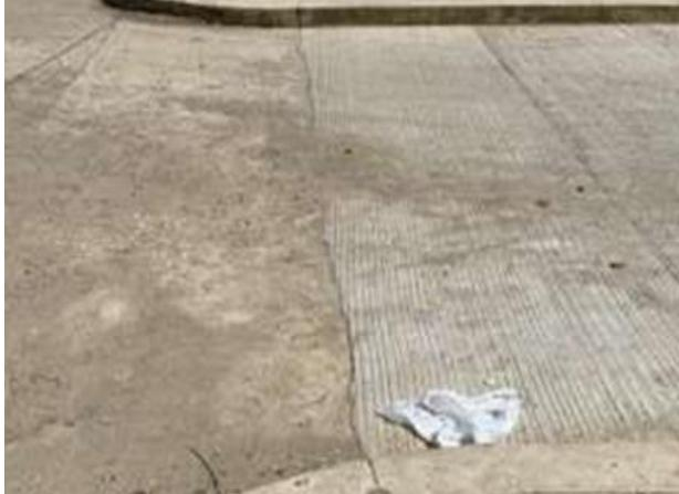
Ilustración 30. Se requiere dilatar la junta entre el pavimento viejo y nuevo.
