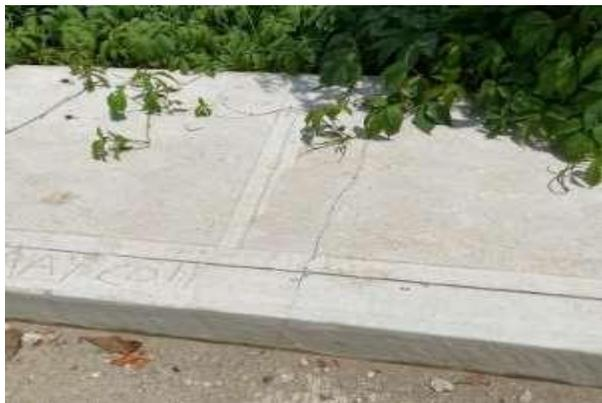
Ilustración 54. Fisura en andén en K0+070.
