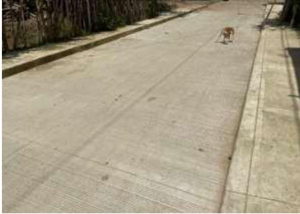
Ilustración 7. Losas con corte superficial longitudinal y transversal desde K0+000 hasta K0+131.
