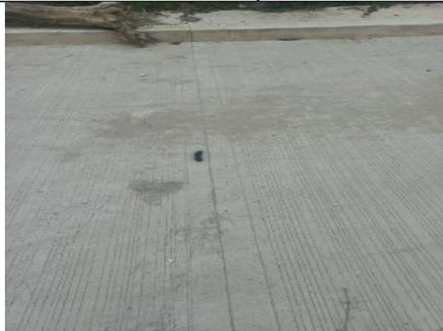
Ilustración 99. Fisura provocada por corte de junta de dilatación.
