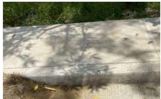
Ilustración 55. Fisura en andén en K0+075.
