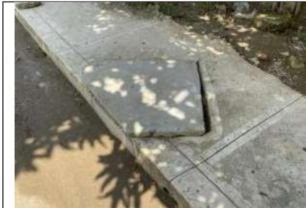
Ilustración 33. Inadecuado acabado de anden con registro, la tapa se encuentra puesta superficialmente.
