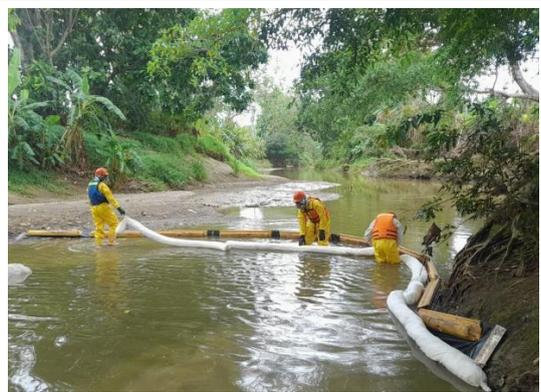
Instalación de barrera mecánica y barrera absorbente
