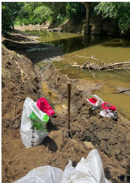
Figura 2 A y B : Detalle del punto de volcamiento , trabajos de contención y retiro de suelo contaminado.
