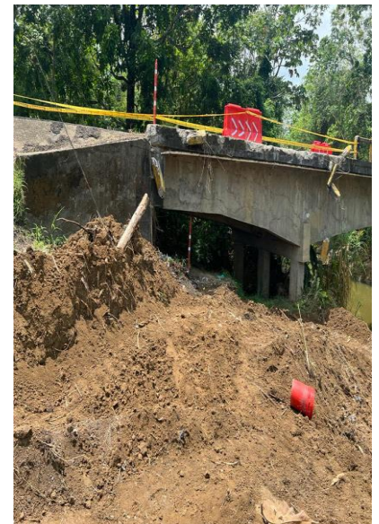
Figura 2 A y B : Detalle del punto de volcamiento , trabajos de contención y retiro de suelo contaminado.
