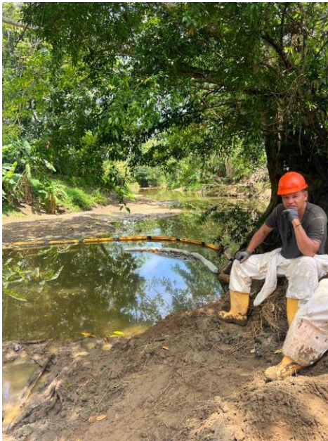
Figura 3 . A- B Detalle de las dos barreras de contención sobre el río CAIMAN como medida de seguridad para evitar contaminación ante el movimiento del vehículo y movimiento de suelo contaminado
