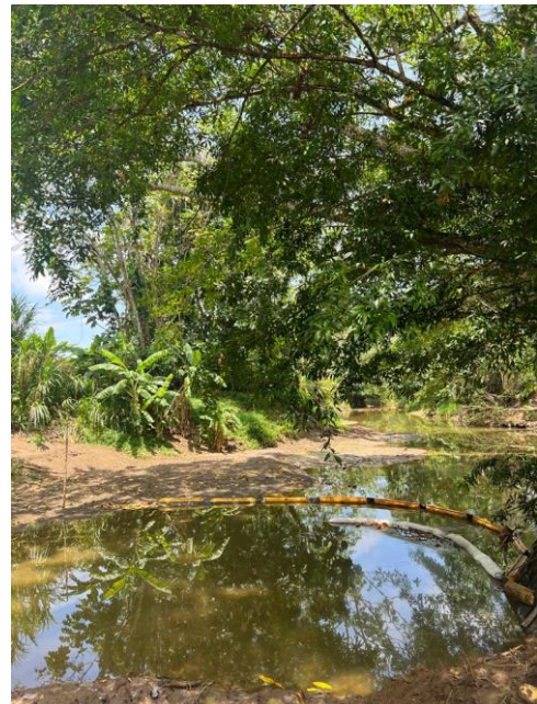
Figura 3 . A- B Detalle de las dos barreras de contención sobre el río CAIMAN como medida de seguridad para evitar contaminación ante el movimiento del vehículo y movimiento de suelo contaminado
