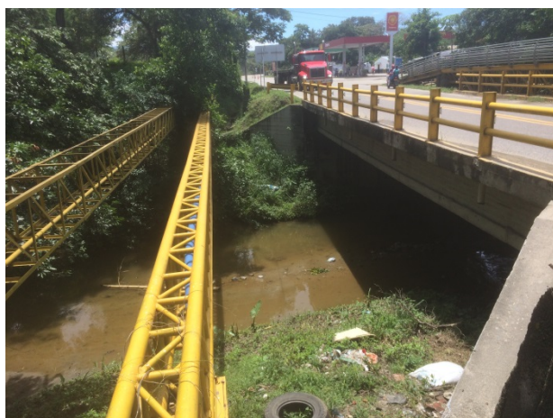
La tubería de gas (izq) pasa por su propia estructura Tubería de gas paralela a la vía, protegida por concreto.
