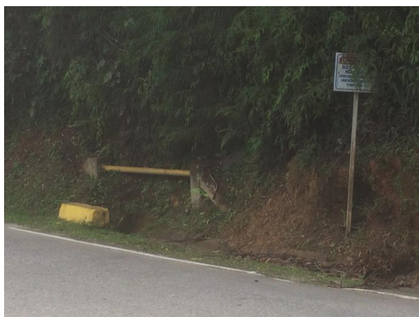
La tubería de gas (izq) pasa por su propia estructura Tubería de gas paralela a la vía, protegida por concreto.
