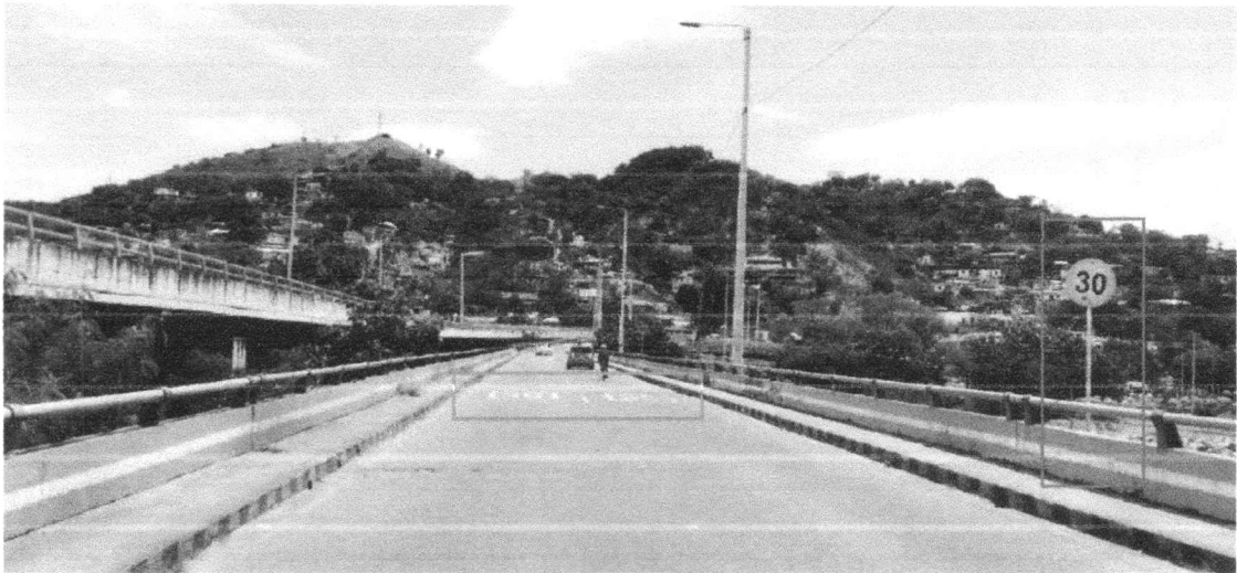
IMAGEN No 04 Registro fotográfico tomado al interior del puente san Rafael del municipio de Cúcuta por donde pasa el rio pamplonita, en este punto de la vía con recuadro de color verde se indica la instalación de señal vertical de velocidad máxima 30 kilómetros por hora, instalada al costado derecho de la vía, doscientos sesenta (260) metros antes del sitio de ocurrencia del accidente de tránsito, con recuadro de color fucsia se indica demarcación de símbolos de velocidad máxima permitida 30 km/h, demarcadas sobre ambos carriles de circulación vial, doscientos cincuenta (250) metros antes del sitio de ocurrencia del accidente de tránsito.
