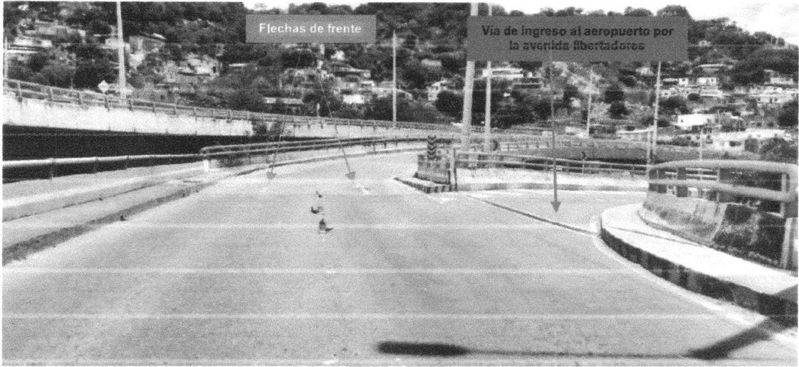
IMAGEN No 08 Registro fotográfico tomado al interior del puente san Rafael del municipio de Cúcuta por donde pasa el rio pamplonita, con flecha de color verde se indica Vía de ingreso al aeropuerto por la avenida libertadores y con flechas de color rojo se indica demarcación de flechas de frente instaladas ciento sesenta (160) metros antes del sitio de ocurrencia del accidente de tránsito.
