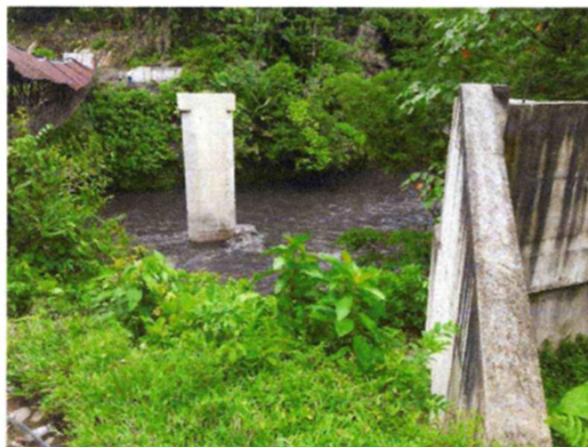
Pila central y estribos
