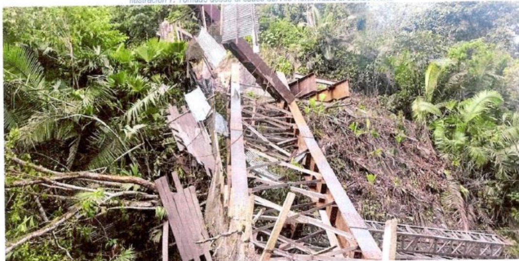
Ilustración 7: Tomado desde el cauce del Río Horta hacia el estribo Norte
