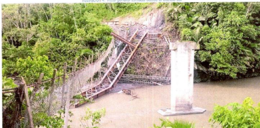
Ilustración 4: Vista general tomada desde el estribo sur
