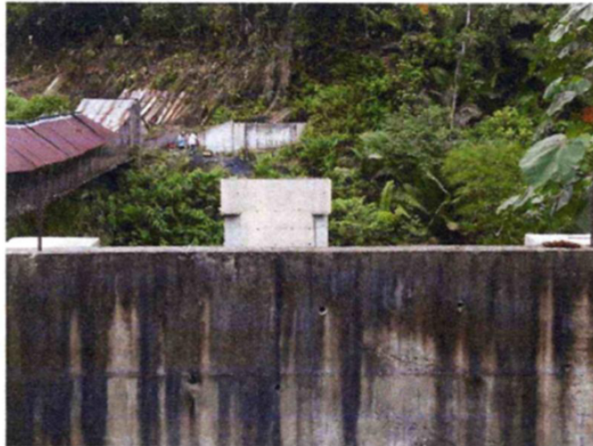
Pila central y estribos
