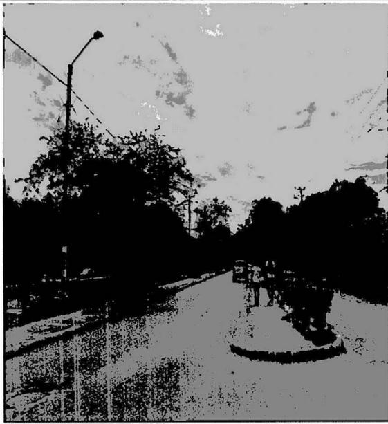
**FOTO 2:** Carrera 2 entre Calles 72 y 72B. Poste de concreto con Luminaria de 150w.
