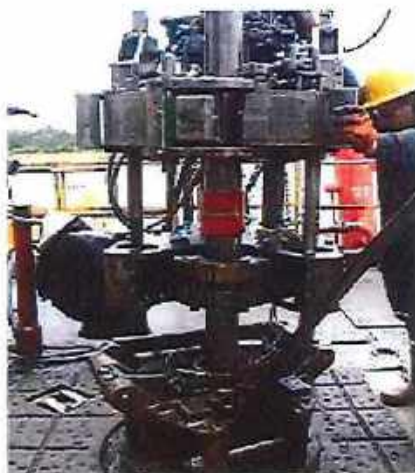
Foto No. 11 Inicio de Roscado con Llave Hidráulica
