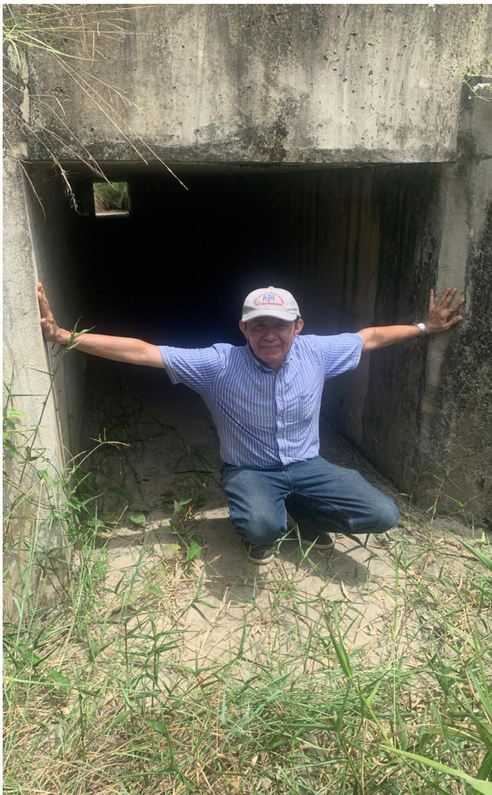
FOTO 14: ALCANTARILLA TIPO BOX CON BUENA SECCION
