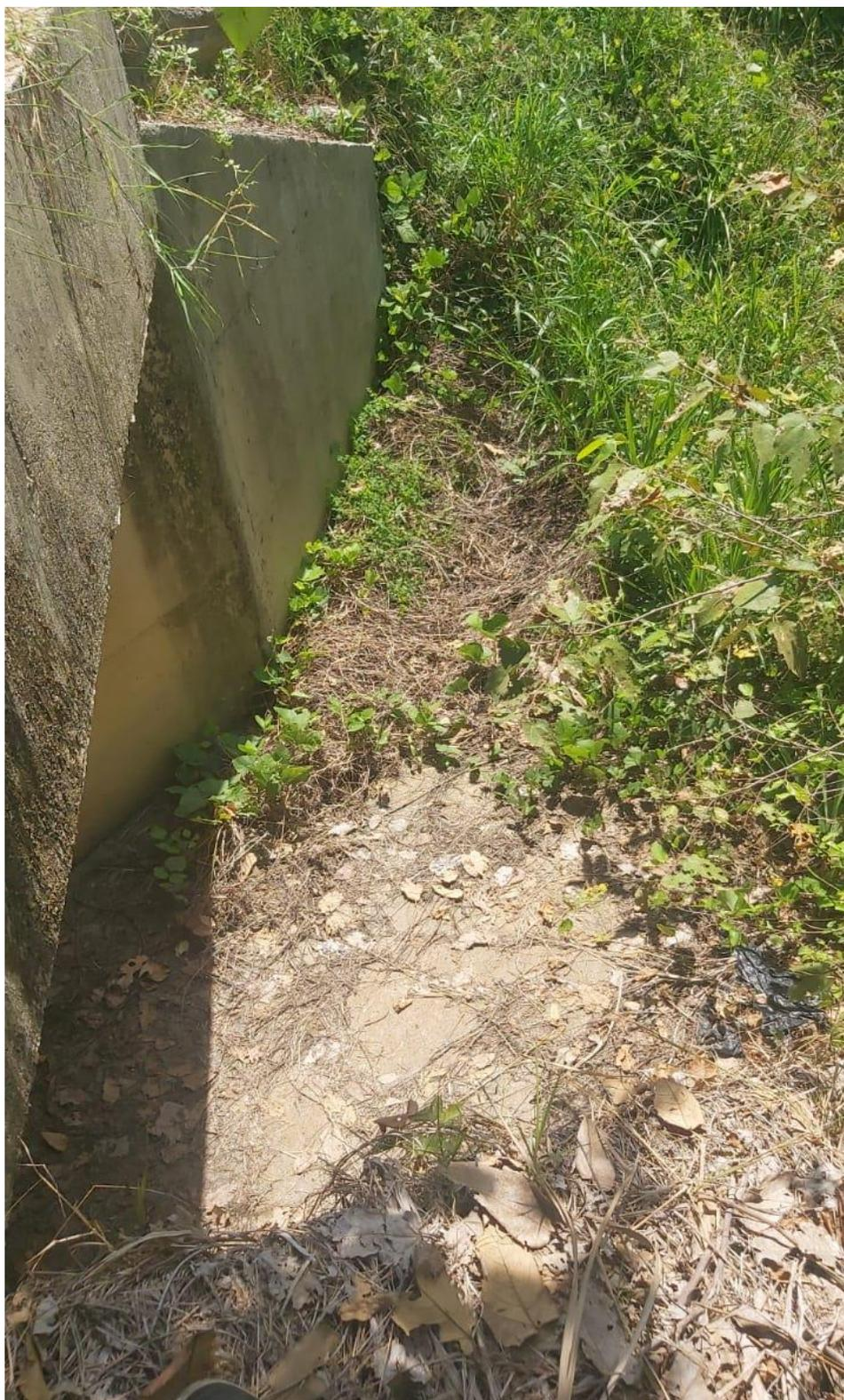
FOTO: 16: DESNIVEL DE ENTRADA DEL AGUA A LA ALCANTARILLA
