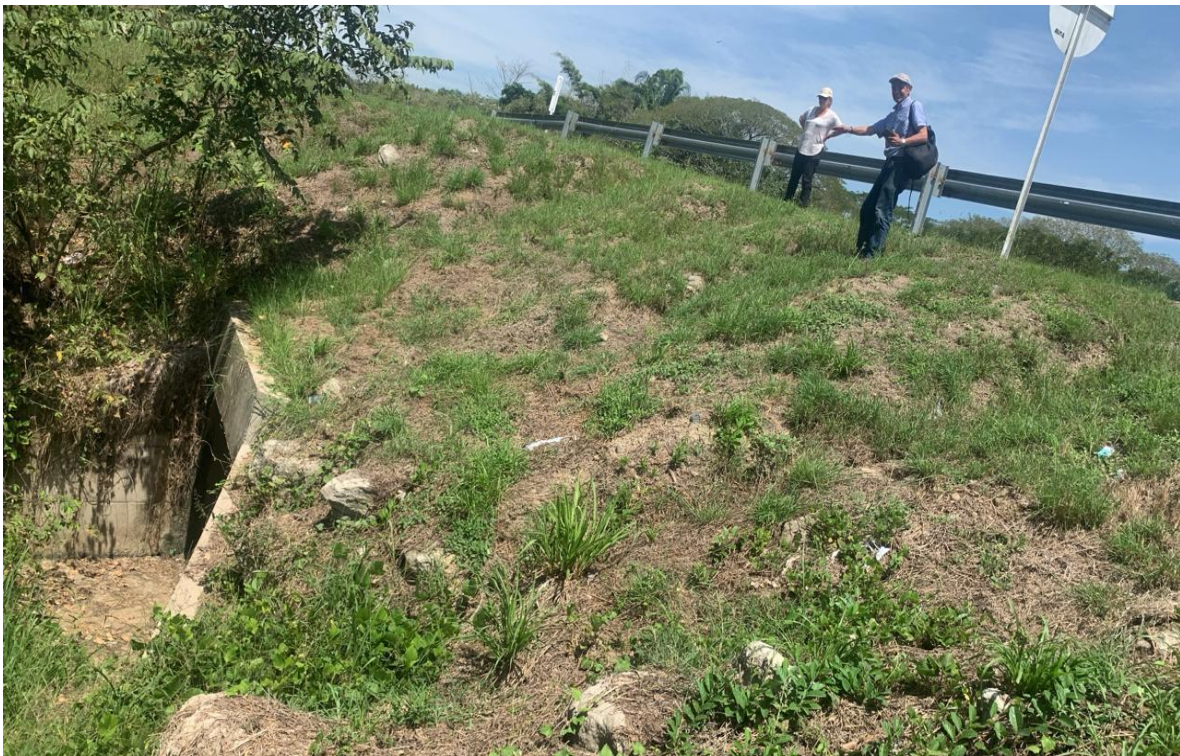
FOTOS 3Y4: VIA Y ALCANTARILLA TIPO BOX
