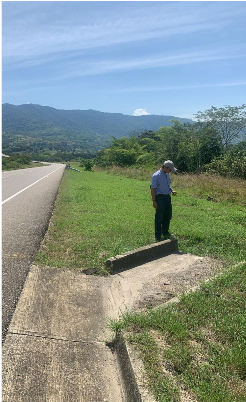
FOTO 7: RECORRIDO POR LAS OBRAS ALEDAÑAS A LOS PREDIOS
