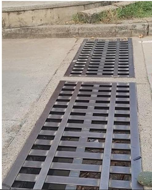
Se observa las marcas intentando abrir la rejilla, cortaron los puntos de soldadura con pulidora,
