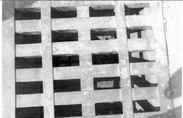
IMAGEN No 17. Se muestra el interior de la alcantarilla.
