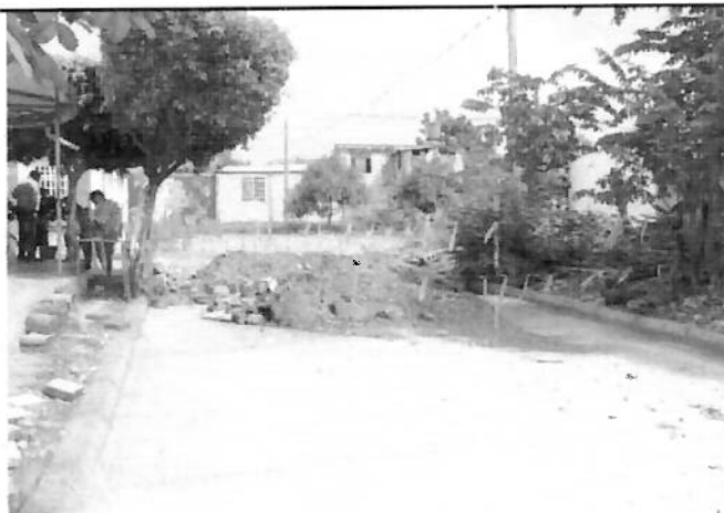
IMAGEN No 1. Se realiza fijación del lugar de los hechos de plano general.
