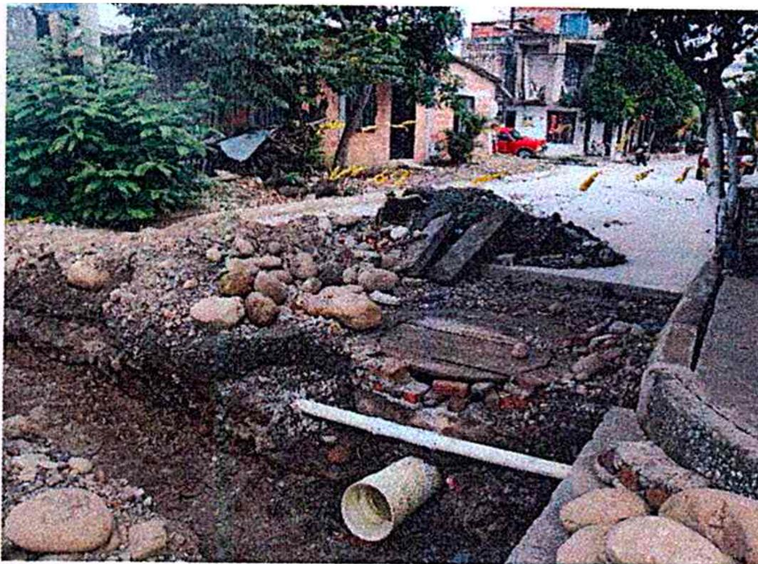
Como se observa de la fotografía, el tubo PVC, esta sin rejilla, el sumidero tiene unas tablas y una parte descubierta pero no tiene piedras sobre los listones de madera, como errónemanete afirma el informe y no existe acordonamiento desprende del las fotografías
