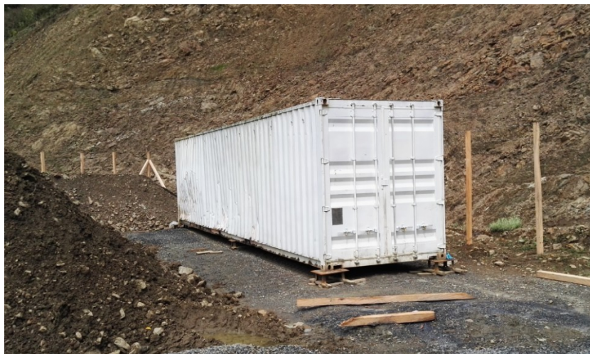
Contenedor con explosivos que fue ubicado en otra zona de la planta mientras se definía su manejo. Se instaló un cerramiento provisional para este polvorín, el cual se mantuvo bajo custodia
