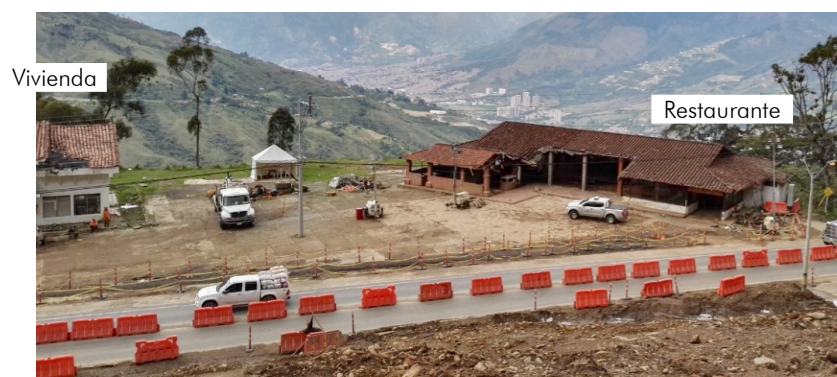
Imagen de las dos edificaciones, parcialmente afectadas
