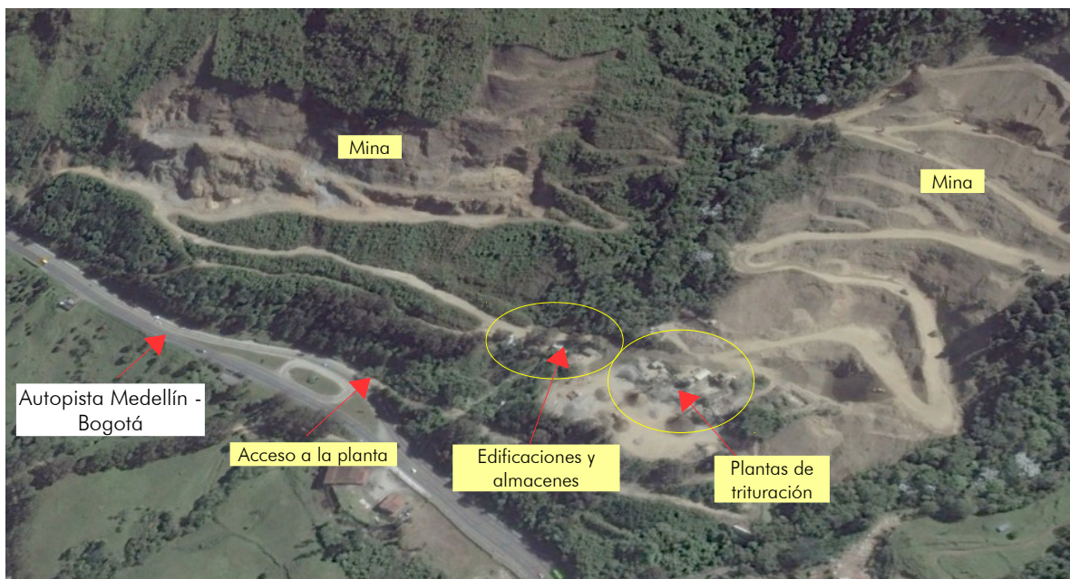
Vista aérea de la planta Las Nieves (antes del deslizamiento)
