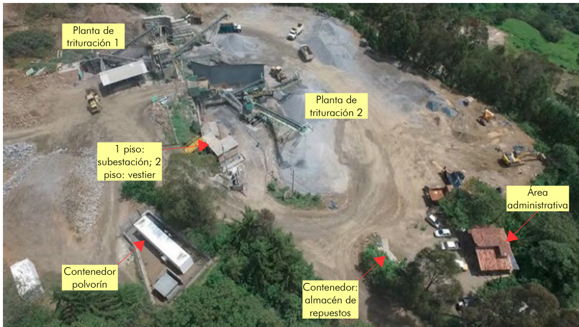
Vista aérea de un sector de la planta asegurada (antes del deslizamiento). Se muestra la ubicación de la zona administrativa, contenedor para almacenamiento de repuestos, edificio para subestación y vestier, plantas de trituración y un contenedor en donde se almacenaban explosivos
