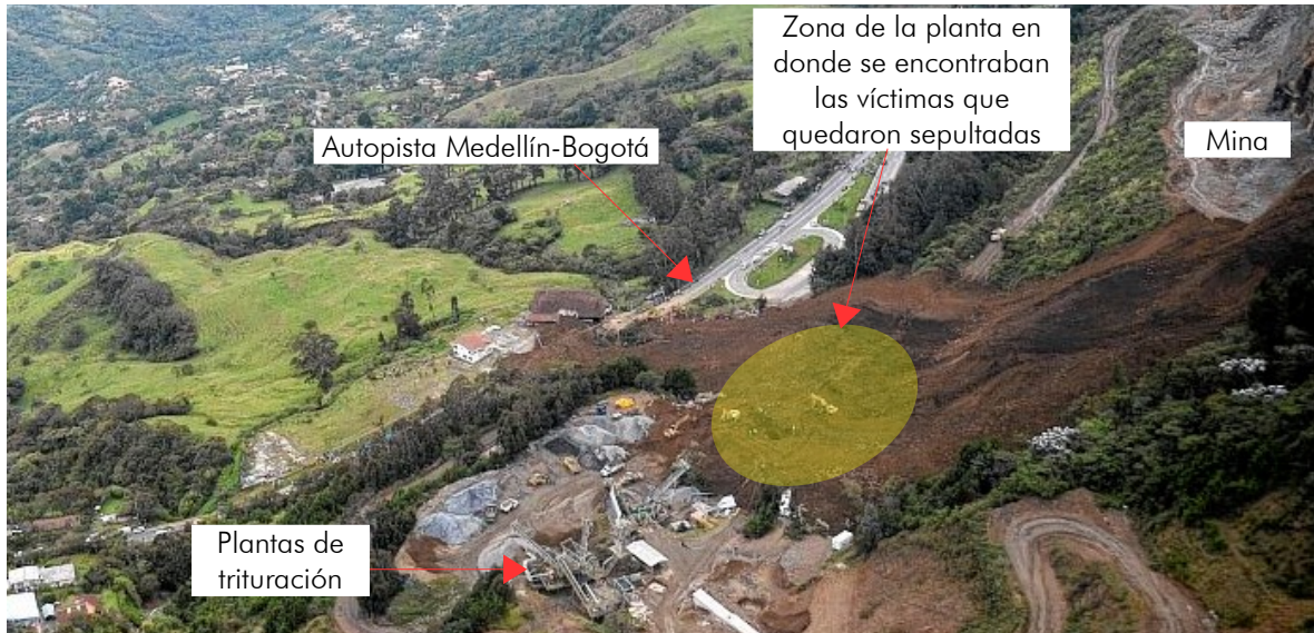
Vista aérea de la planta y de la zona que resultó sepultada por el deslizamiento
