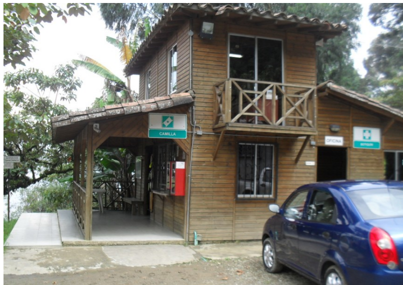
Casa ocupada por el área administrativa de la planta (imagen tomada por Siar durante la evaluación del riesgo)
