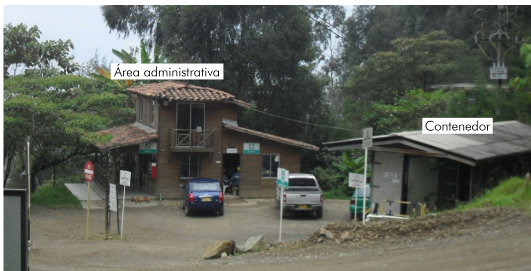
Área administrativa y contenedor de repuestos
