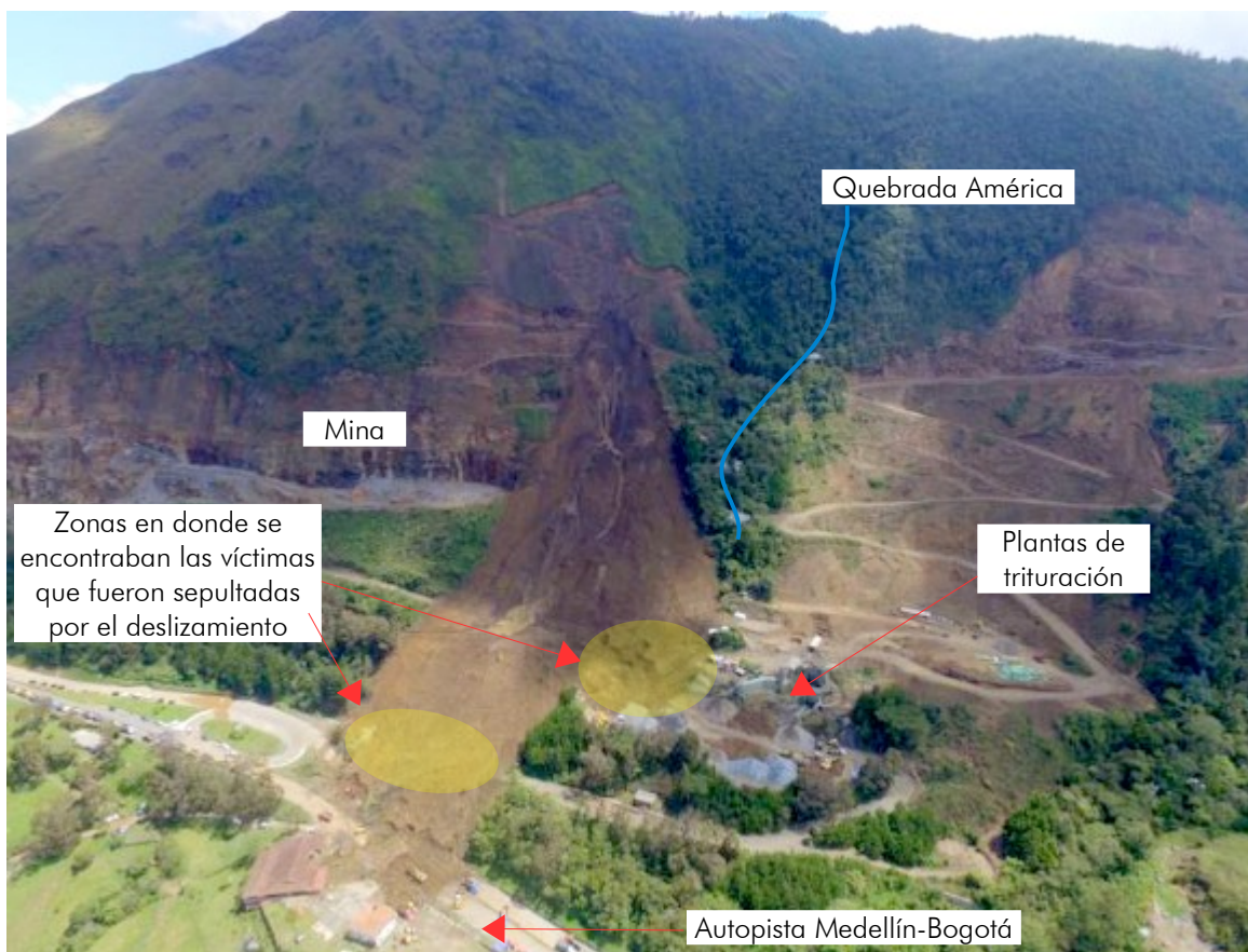
Imagen de la zona afectada. Se señala el área donde se encontraba la parte de la planta asegurada que fue destruida por el deslizamiento. Las líneas de trituración no resultaron afectadas. Parte del material deslizado cayó sobre la vía que conduce de Medellín a Bogotá. El predio es atravesado por la quebrada América
