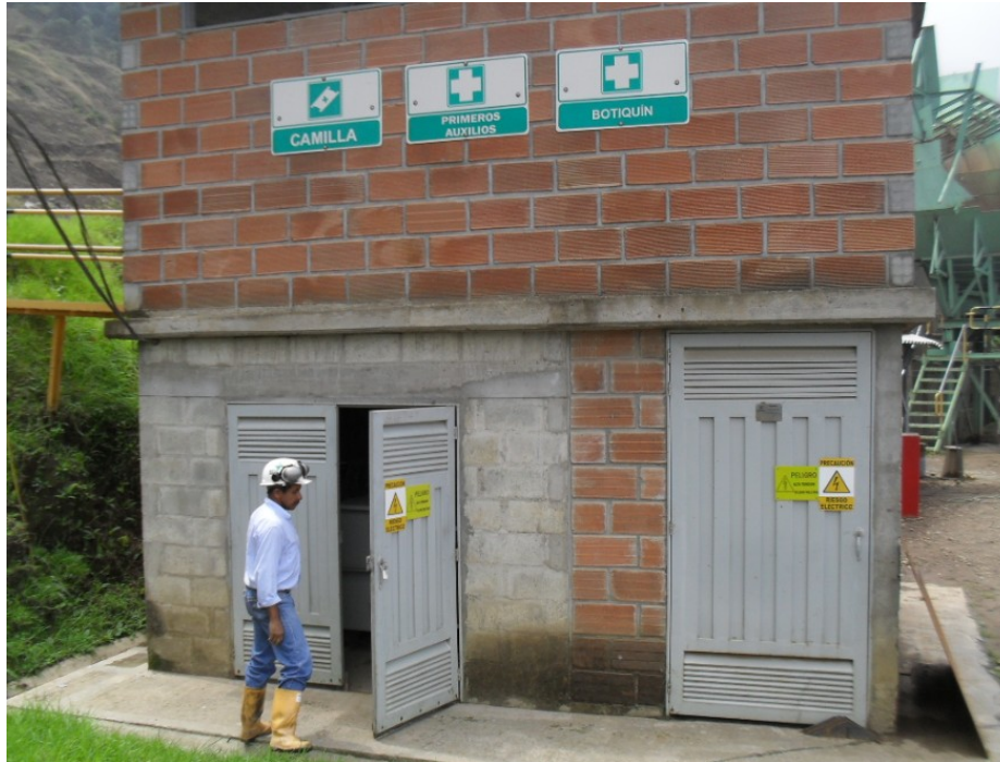
Edificación en donde se ubicaban el vestier (segundo nivel) y la subestación (primera planta)
