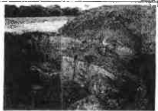
Vista pared lateral de la excavación que presentó caída lateral sobre el personal de trabajadores desde dos puntos diferentes
