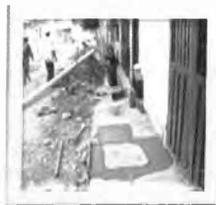
Reposición de andenes en concreto rígido
