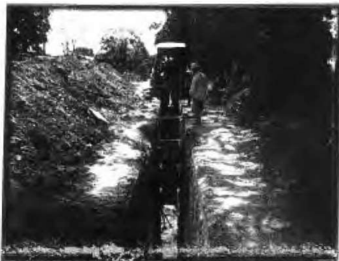
19. Instalación de tubería tramo MHA46-MHA49, Excavación mecánica profundidad=4,8m, entibado, cama de arena, atraque de tubería, instalación tubería con nivel de precisión.
