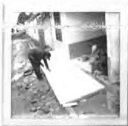
Reposición de cerámica de andenes que fue necesario romper
