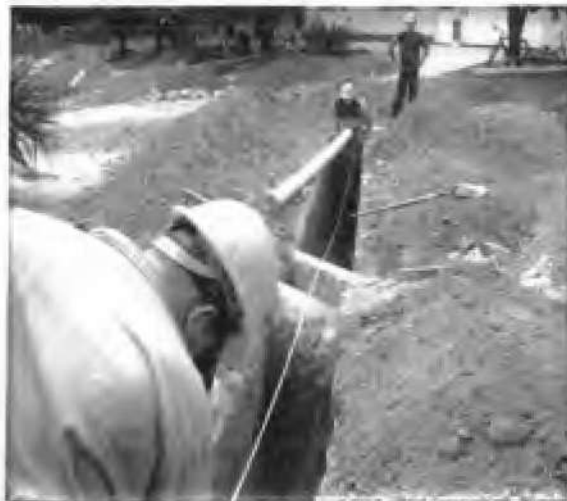
EXCAVACION E INSTALACION DE TUBERIA SANITARIA DE 6", PARA LA DOMICILIARIAS
