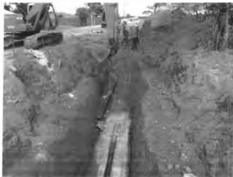
TUBERIA SOBRE CAMA DE ARENA
