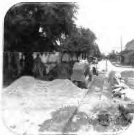
Compactación de material para reposición de concreto rígido
