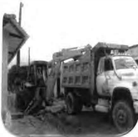
Excavación y retiro de materiales
