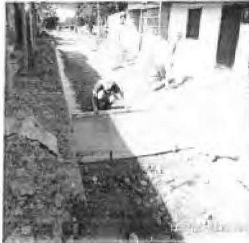
REPOSICION DE PAVIMENTO RIGIDO
