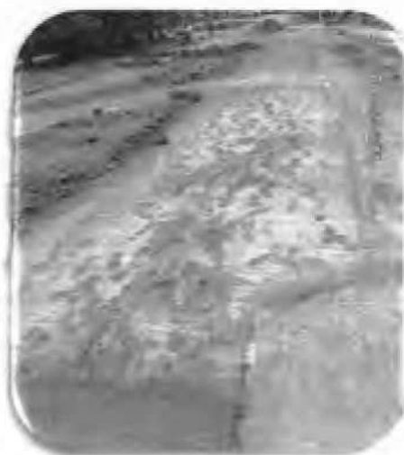
Daños en la reposición de pavimento rígido
