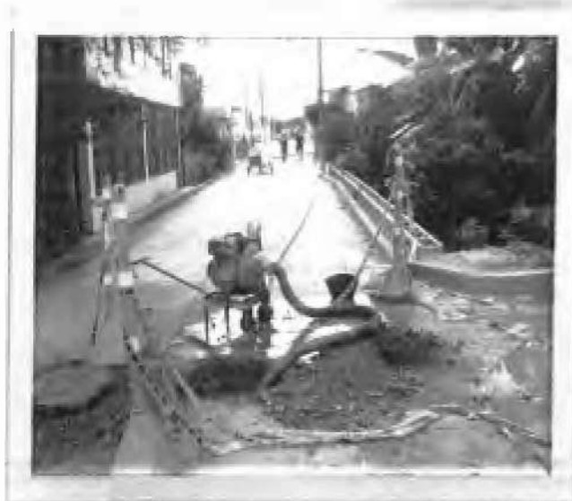
MANEJO DE AGUAS, TANTO LLUVIAS COMO POR NIVEL FREATICO ALTO
