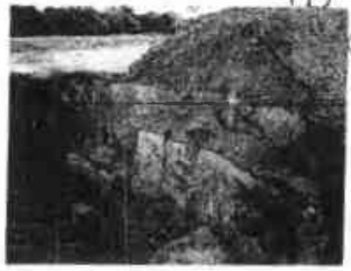
Vista pared lateral derecha de la excavación que presenta caída lateral sobre el personal de trabajadores desde dos puntos diferentes
