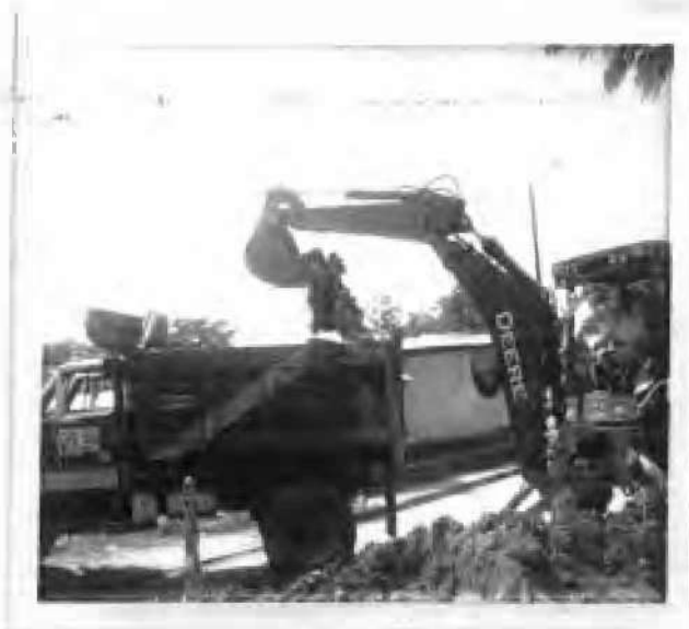
RETIRO DE SOBRANTES PROVENIENTES DE LA EXCAVACION
