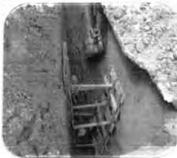
Excavaciones y entibados
