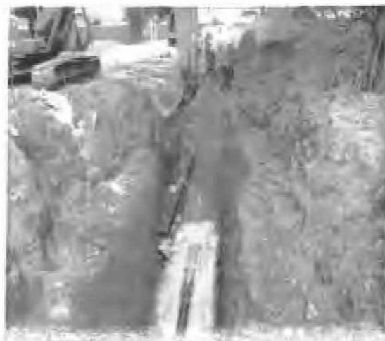
TUBERIA SOBRE CAMA DE ARENA
