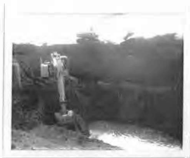
EXCAVACIONES MAYORES A 3 M.D. Y PROFUNDIDAD, CON DOS RETROEXCAVADORAS DE ORUGA
