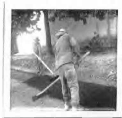
REPOSICION DE CONCRETO FLEXIBLE EN DONDE SE INSTALO LA TUBERIA SANITARIA DE 8"
