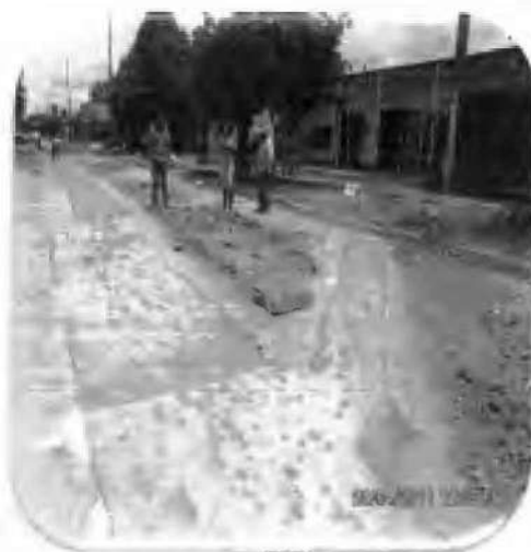
Daños en la reposición de pavimento rígido
