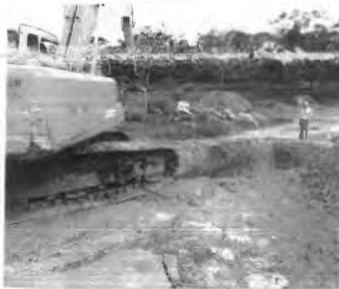
EXCAVACION PARA INSTALACION DE TUBERIA, VIA NACIONAL
