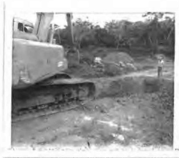
EXCAVACION PARA INSTALACION DE TUBERIA, VIA NACIONAL
