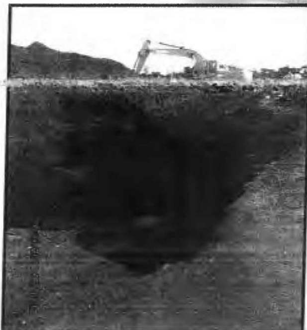
FALLA VERTICAL DEL TERRENO
