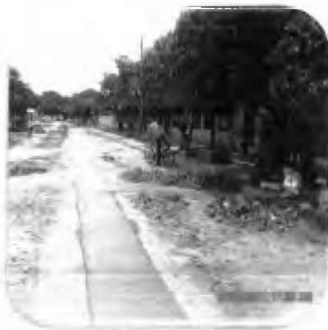
Reposición de concreto rígido
