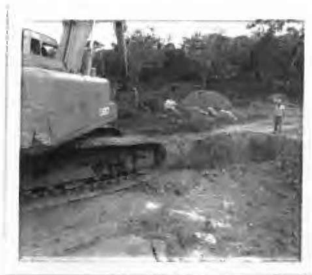
EXCAVACION PARA INSTALACION DE TUBERIA, VIA NACIONAL.
