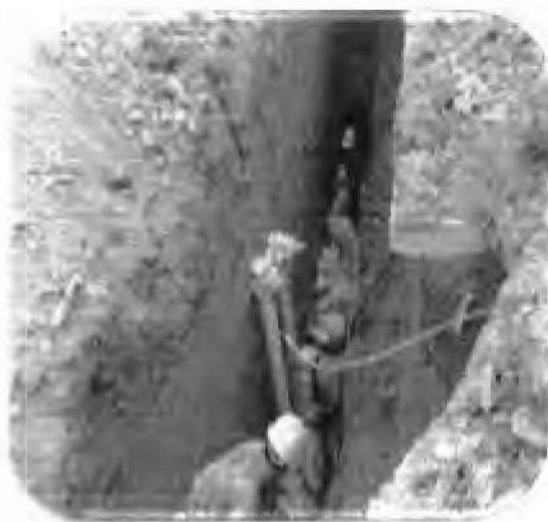
Instalación de tubería
