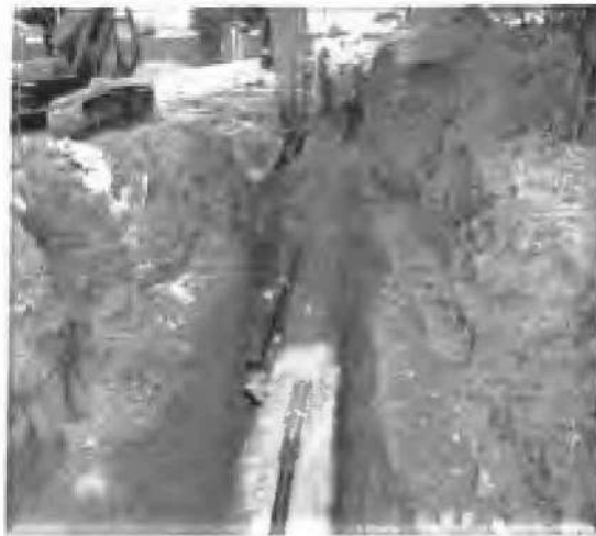
TUBERIA SOBRE CAMA DE ARENA
