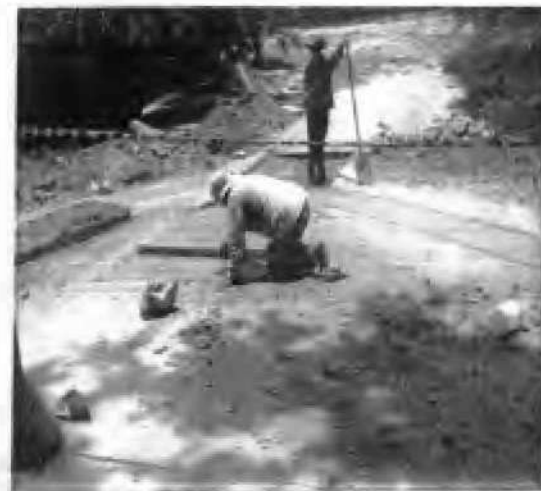
REPOSICION DE CONCRETO RIGIDO EN DONDE SE INSTALO LA TUBERIA DOMICILIARIA
