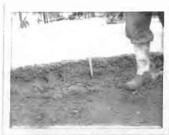
REPOSICION DE PAVIMENTO RIGIDO
