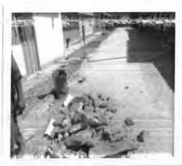
DEMOLICION MANUAL DE PISOS Y ANDENES
