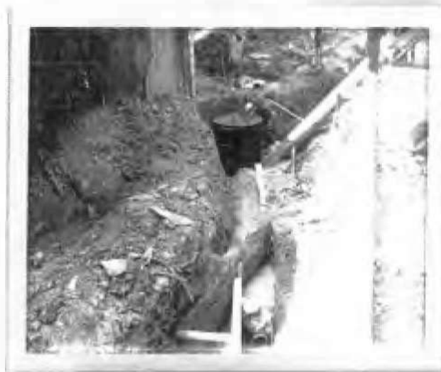
CONSTRUCCION DE POZOS DE INSPECCION
