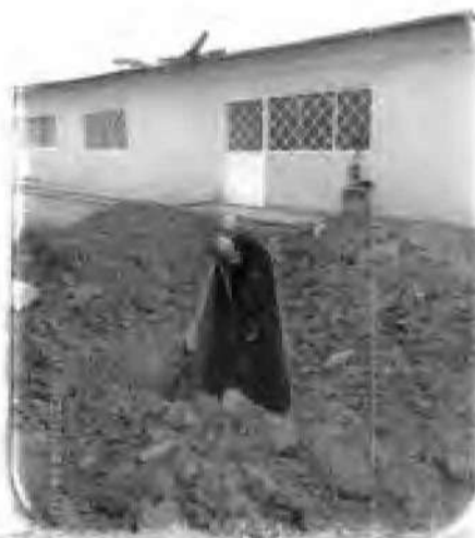
Corte y excavación de domiciliarias
