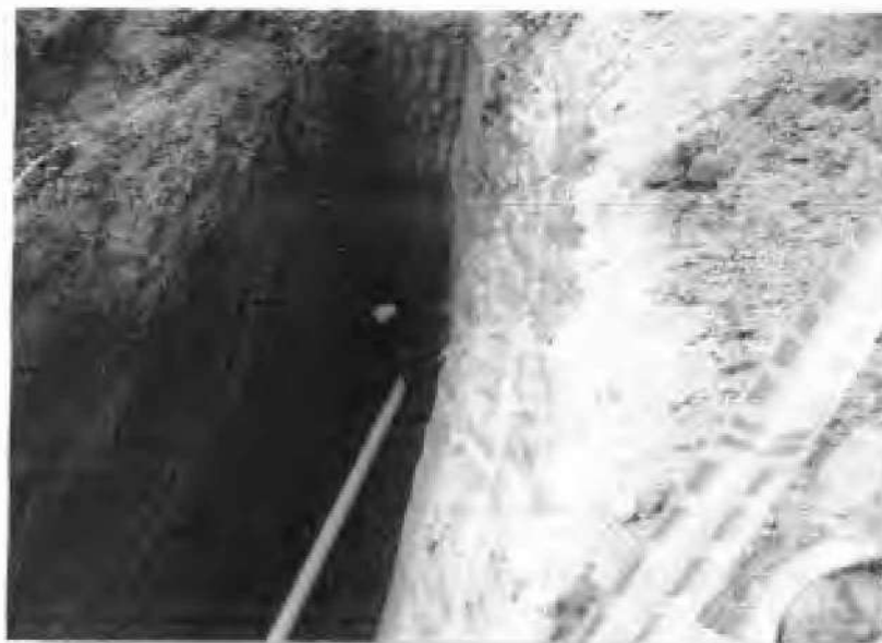
INSTALACION DE TUBERIA DE 8" PVC
