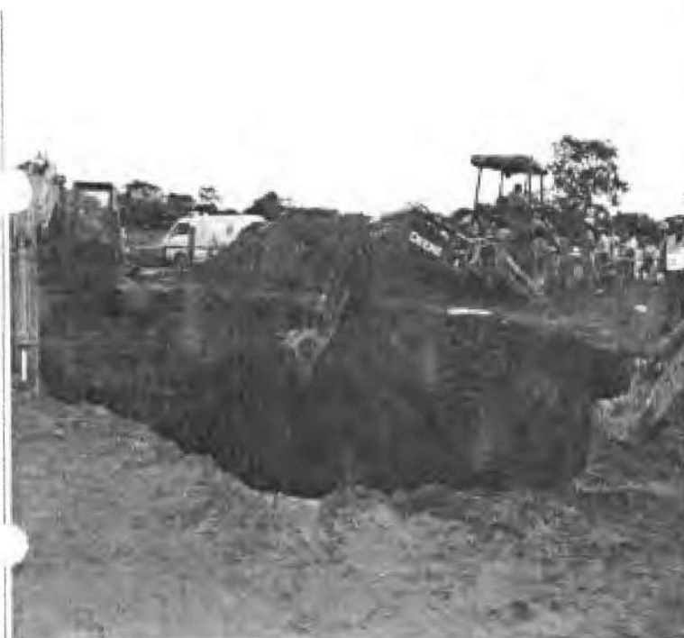
IMAGEN 03: SE OBSERVA IMAGEN DE LA ESCABACION EN DONDE OCURRIERON LOS HECHOS.
