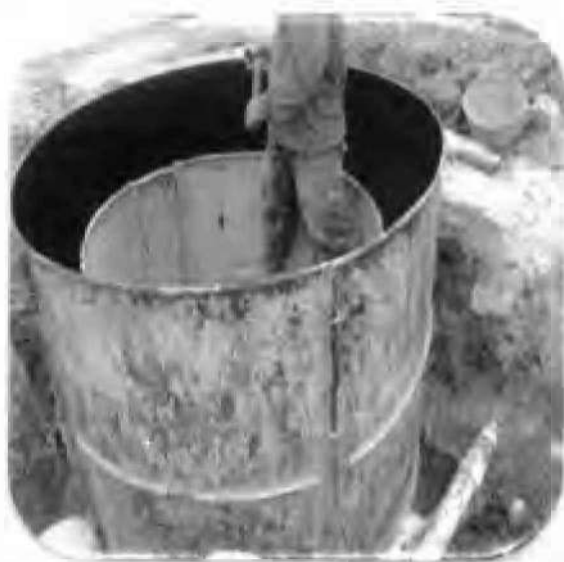
Pozos de inspección
