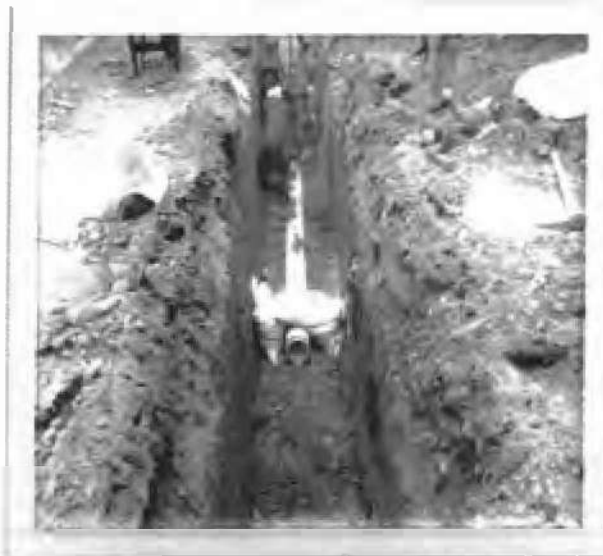
INSTALACION DE TUBERIA DE ALCANTARILLADO SANITARIO DE 8", CAMA EN ARENA Y CUBRIMIENTO CON MATERIAL PROVENIENTE DE LA EXCAVACION
