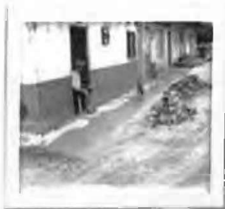
Reposición de andenes en concreto rígido
