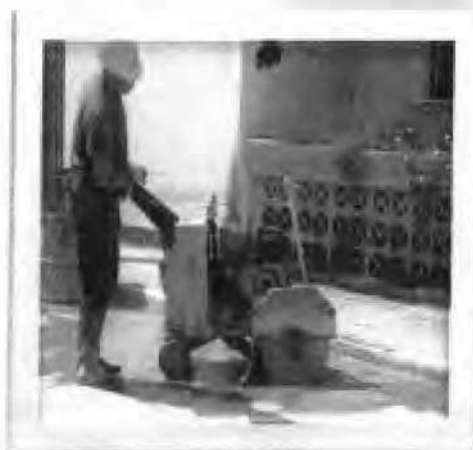
CORTE DE CONCRETO RIGIDO
