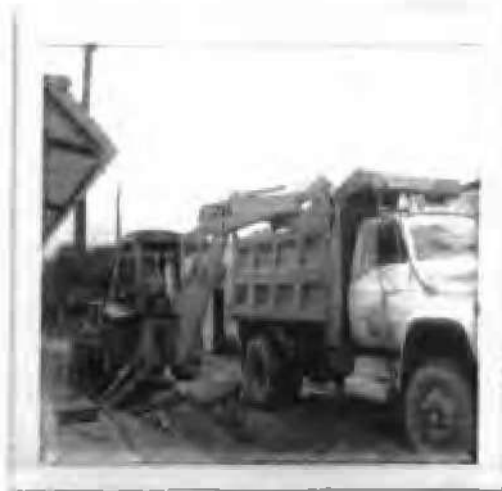
RETIRO DE ESCOMBROS PROVENIENTES DE LA EXCAVACION
