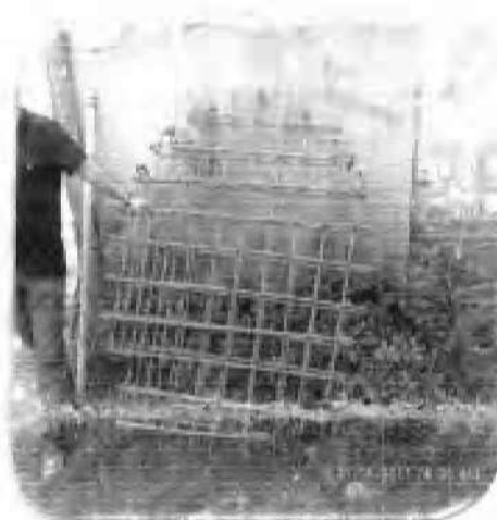
Parillas para pozos de inspección
