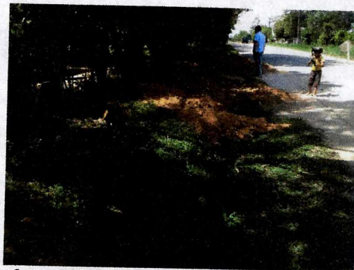
Registro fotográfico lugar sitio donde se instaló tubería
