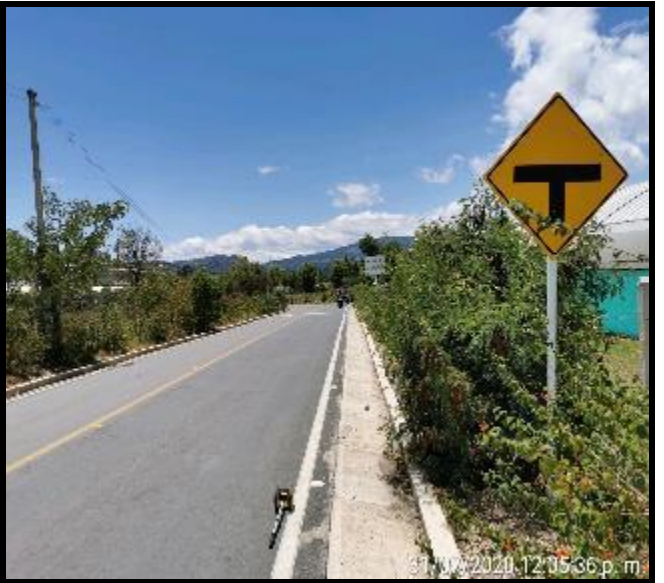
CARRETERA Sutamarchan - Punta Del Llano 52247 PR 6+0097 DESCRIPCION Señal Preventiva - SP 14 Intersección en T Costado Derecho
