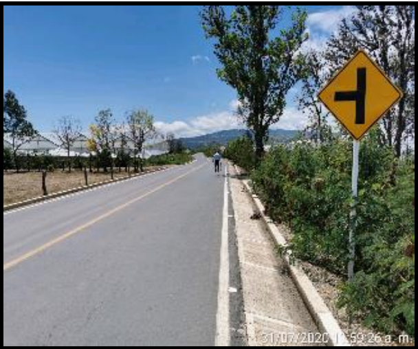
CARRETERA Sutamarchan - Punta del llano 52247 PR 5+0715 DESCRIPCION Señal Preventiva - SP 12 Vía lateral izquierda Costado Derecho
