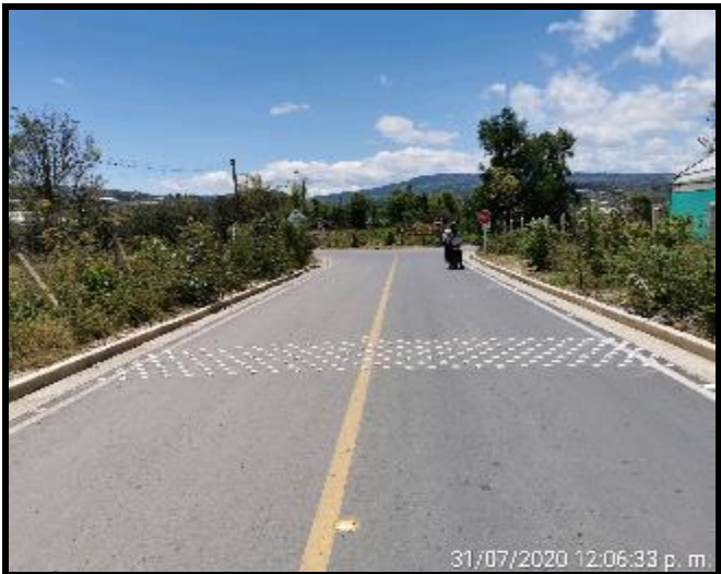
CARRETERA Sutamarchan - Punta Del Llano 52247 PR 6+0096 DESCRIPCION Banda alertadora resaltada transversal Costado Calzada completa
