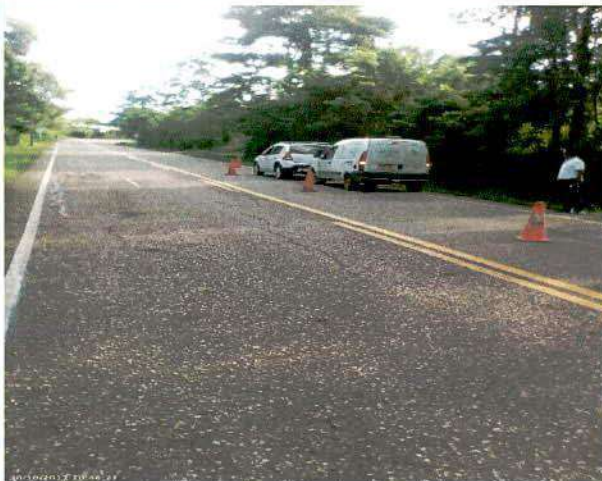
Servicio Mecánico Base Operacional 4
