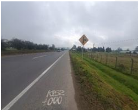
PR40+980 vía lateral a la derecha
