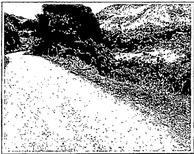
FOTOGRAFÍA DE PLANO GENERAL Nº 1 y 2: Se observa el lugar donde se observa la vía por la cual se sale el vehículo, ubicado en zona rural Sector el Nueve Km 85+900 vía Quibdó – Medellín, vía sin pavimentar sin demarcaciones horizontales de líneas de borde y línea central, costado derecho hay un abismo de aproximadamente 90 metros y pequeños arboles sobre la pendiente, sobre este mismo costado hay una señal de transito preventiva de color amarillo con un letrero de perdida de borde, delineadores tubulares con cinta plástica de demarcación y parte de esta cinta
