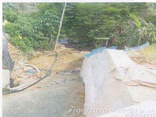
Proceso de socavación y remoción en masa identificado sobre el cauce aproximadamente a 20 metros aguas abajo del proyecto
