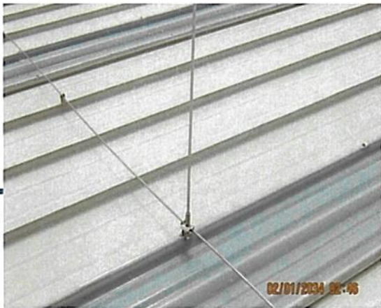
Fig2 Soportes de aislador con chazo para anillo perimetral de alambón, marca Propster Ref 111003
