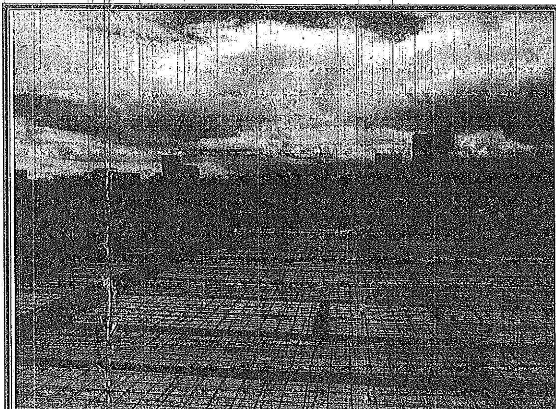
Alistamiento de formaleta y acero para placa de cubierta
