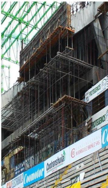
1. No se observan arriostramientos diagonales en el nivel de la losa de cabinas de radio y prensa (Nivel 467.15)
