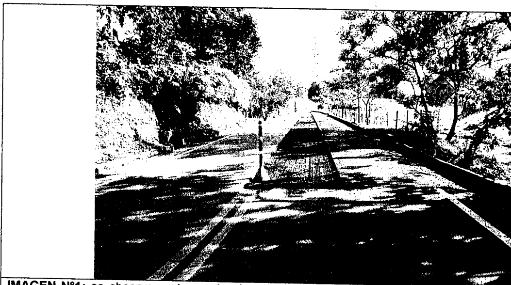
IMAGEN N°1: se observa un tramo de vía recto, una calzada, dos carriles, doble sentido de circulación, sentido vial Mocoa - Santana. Se aprecia que la señalización horizontal (línea central doble continua) llega hasta una parte de la calzada y luego desaparece al igual que la línea de borde color blanco, debido a que se adelantan unos trabajos de reparación del tramo de vía. No se observa señalización vertical que advierta a los usuarios de la vía sobre los trabajos que se adelantan sobre la malla vial.
