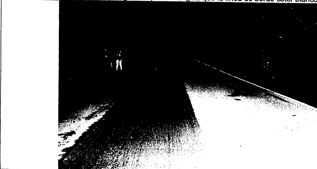
IMAGEN N°2: se observa tramo de vía sentido vial Santa Ana – Mocoa, evidenciando que la superficie de rodadura se encuentra en estado de reparación, la señalización horizontal (línea central) no está demarcada y la línea de borde lado izquierdo es poco visible además el lugar carece de iluminación artificial.
