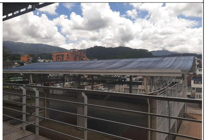
Se observa falta de seguimiento a recomendaciones a manual de uso y mantenimiento, obsérvese deformación de cubierta de polideportivo
