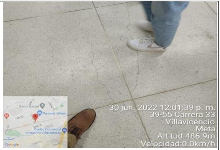
Durante recorrido se observa fisuras en todos los pisos de granito pulido
