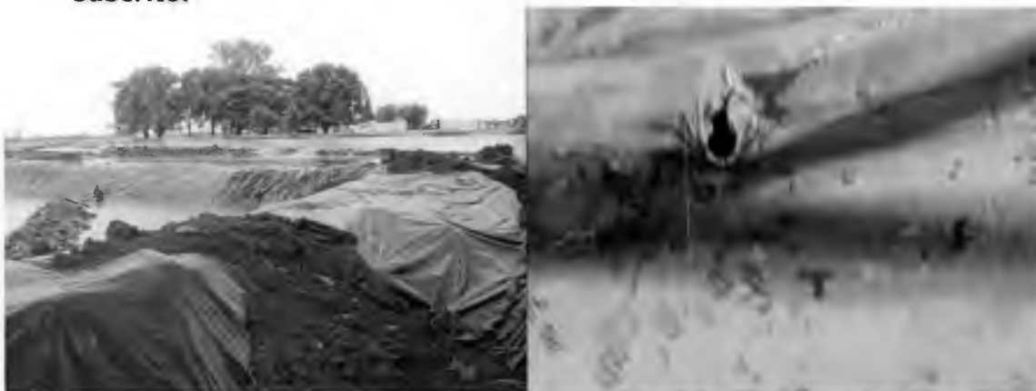
Izquierda Foto. Vista del plástico utilizado para impermeabilizar las celdas. Derecha Foto. Vista de la calidad del plástico utilizado por ECODING.
