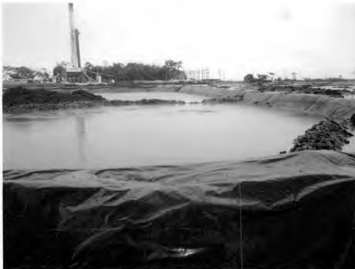
Foto: Vista panorámica de las celdas. Nótese la falta de cubrimiento para evitar la afectación con las aguas lluvias.
