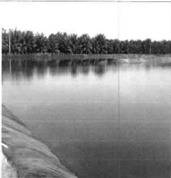
Laguna de oxidación en funcionamiento
