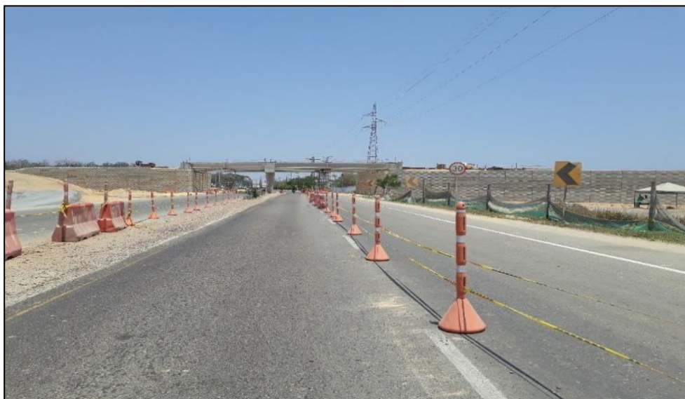
Imagen 1. Señalización del 10 de abril de 2018. Obra Intersección PIMSA, con delineadores tubulares compuestos unidos con cinta peligro tanto en el cierre de carril, como en el cierre del separador.
