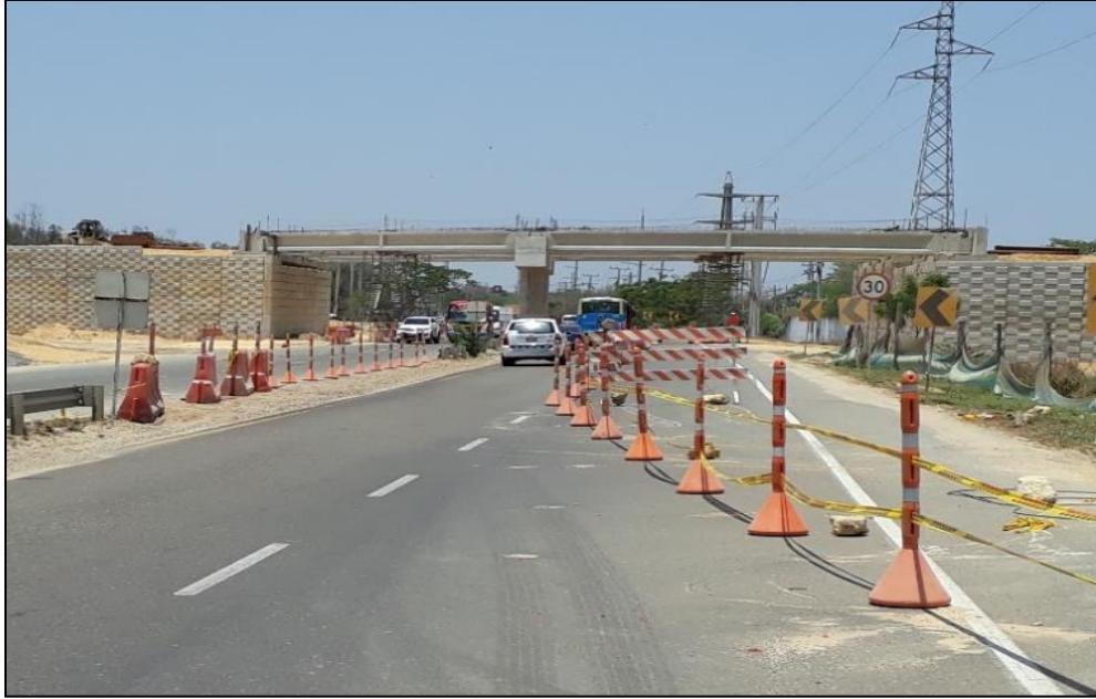
Imagen 2. Barricada de listones, faros flasher y transición con delineadores tubulares compuestos en la intersección de PIMSA.
