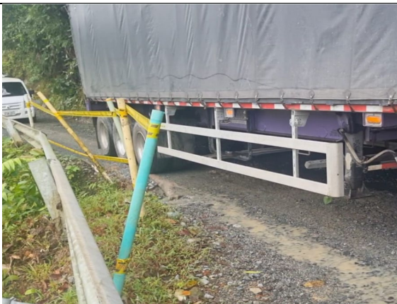
Maniobra Peligrosa que camiones y tractocamiones deben realizar por este tramo de vía.
