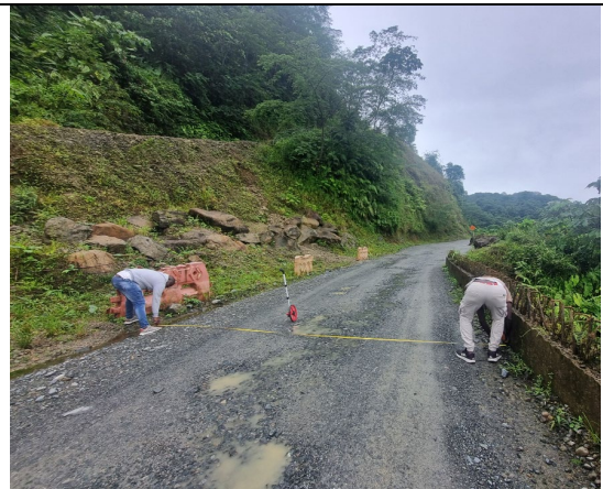
Medición ancho-calzada muro contención
