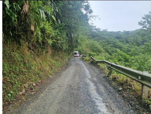
Tramo recto de aproximadamente 60 metros en los cuales el ancho promedio de calzada no supera los 4m
