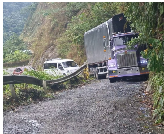
Dificultad en la que un tractocamión que frecuentemente transitan por esta vía debe maniobrar en K44+600 cuyo ancho de calzada no supera los 5m
