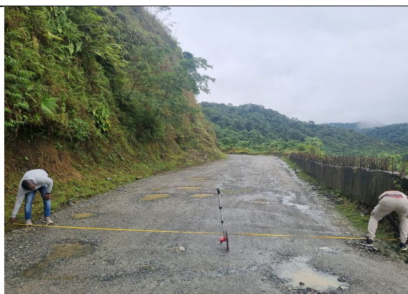
Medición ancho-calzada muro previo al sitio del accidente
