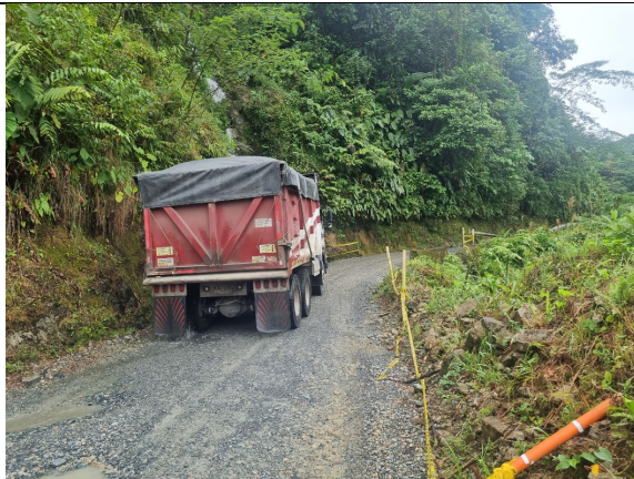
Ancho Calzada insuficiente para dos vehículos en sitio accidente, mal estado señalización cinta peligro Ausencia de barreras viales o defensas metálicas
