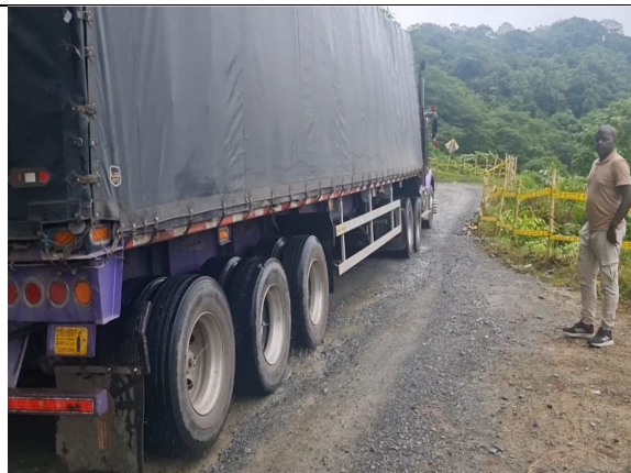
Falta de visibilidad que puede generar dificultades en el momento que otro vehículo en sentido contrario llegue al sitio, se observa sobre anchos de calzada que solo sirven para vehículos menores.
