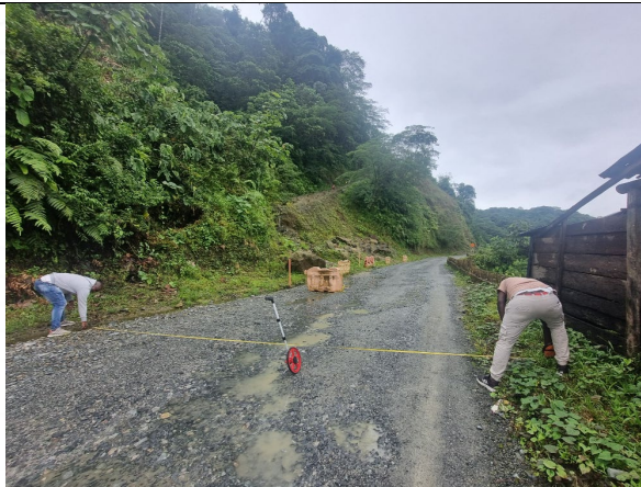
Medición ancho-calzada tramo inicial
