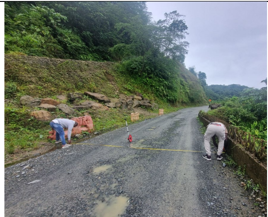
Medición ancho-calzada muro contención
