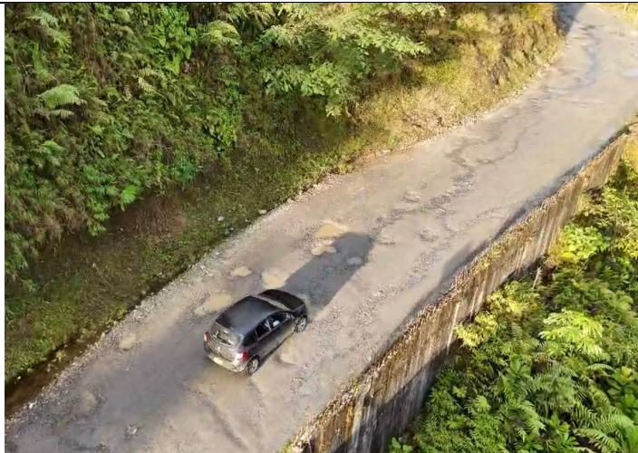
Se evidencia en esta imagen aérea Muro de contención #2 que fue construido posterior a la fecha del accidente evidenciando la necesidad de estabilizar la calzada.
