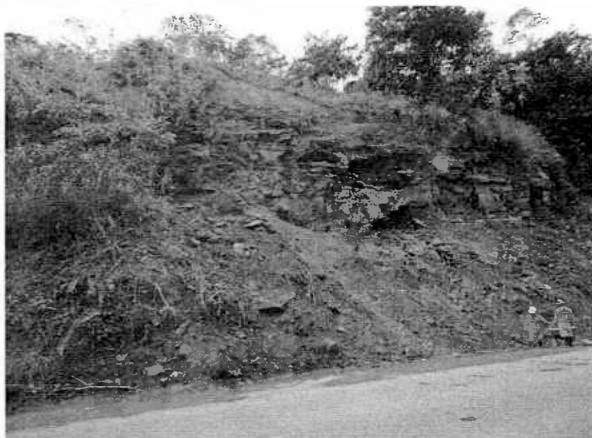
Fotografía 7. Vista general del sitio K81+500 Fuente: Propia Agosto 2013
