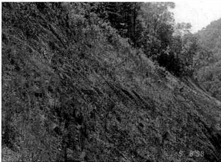
**Fotografía 14. Malla metálica eslabonada, anclada con pernos y acompañada de manto permanente de control de erosión Fuente: Propia**
