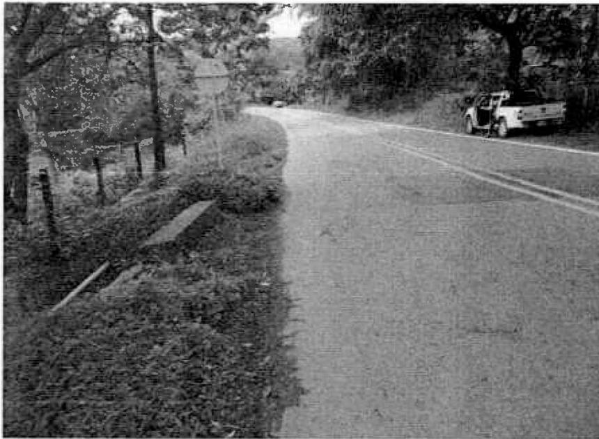
Fotografía 32. Fisuración por descanfinamiento lateral en la banca de la vía Fuente: Propia Agosto 2013
