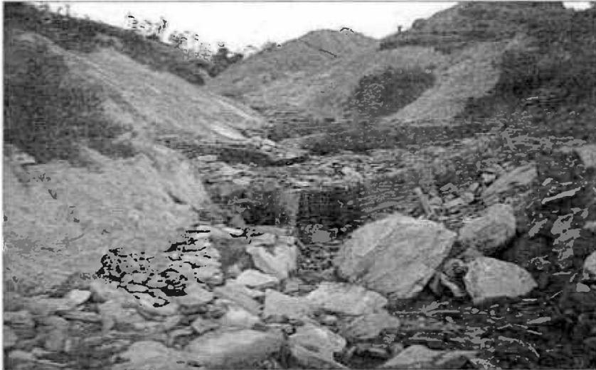
Fotografía 10. Barreras disipación de energía en gavianes Fuente: Propia
