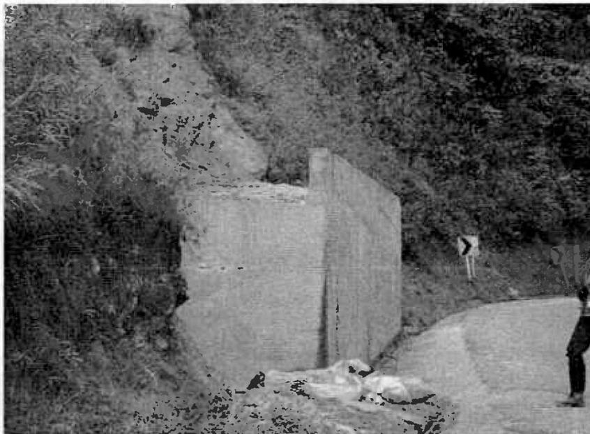
*Fotografía 28. Muro completamente lleno y lloraderos fuera de funcionamiento Fuente: Propia Agosto 2013*
