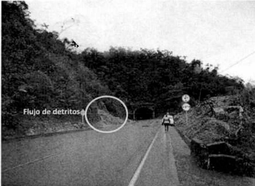
Fotografía 9. Flujo de detritos en salida del túnel en dirección Florencia Orraphiuasi Fuente: Propia Agosto 2013
