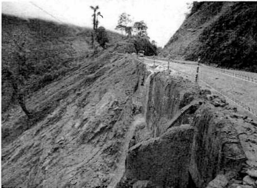
Fotografía 35. Muro de contención cimentado sobre roca Fuente: Propia Agosto 2013
