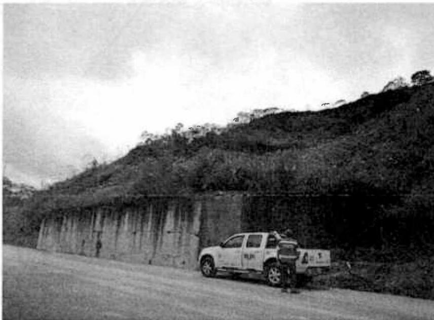
*Fotografía 19. Solución con muro de retención de sólidos, contiguo al sitio con problemas erosivos Fuente: Propia*
